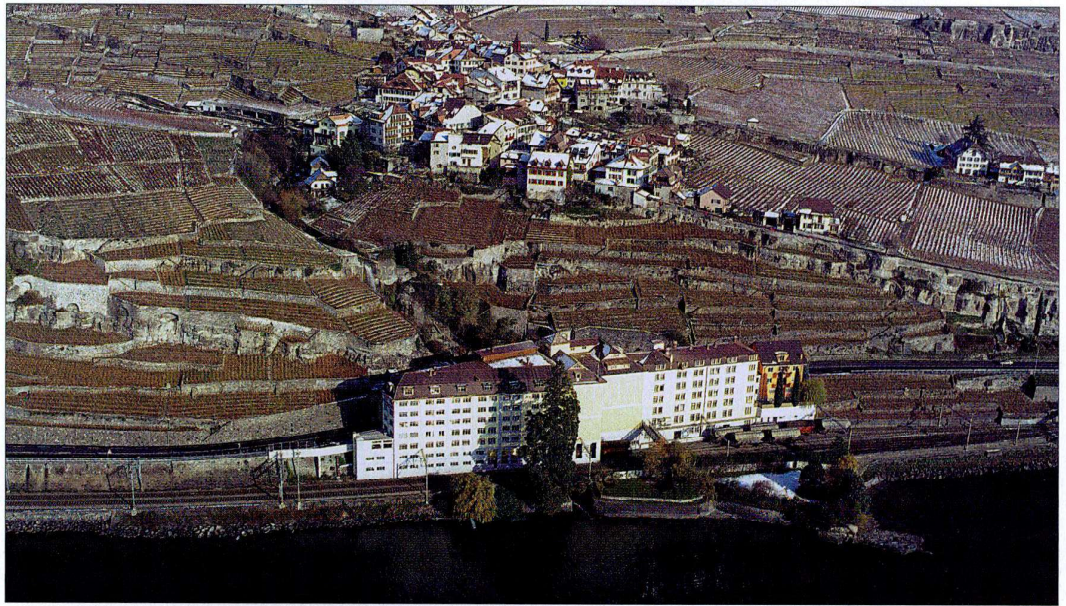
Nicht mehr benötigte Industriebauten: Projekt, «Rückbau zu Rebgeleände» oder Projekt «Umnutzung zum Wohnen?» Chancen für die Revision bestehender Wirkungen mit sehr hoher Eingriffsintensität.
