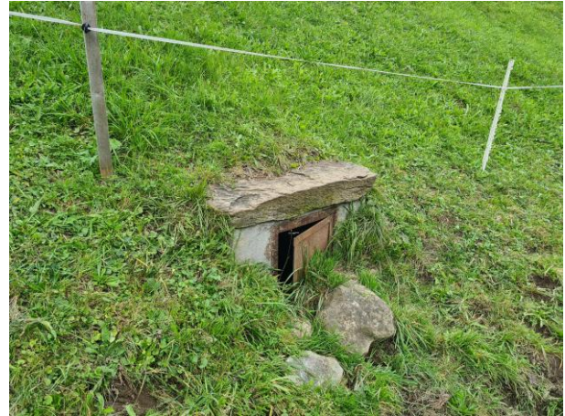
Abb. 7: eingemauerte Quellfassung mit Eisen- tor
