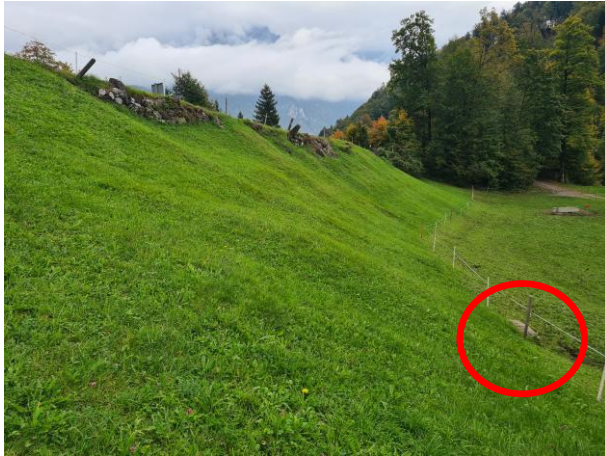
Abb. 6: bestehenden Quellfassung in der Böschung
