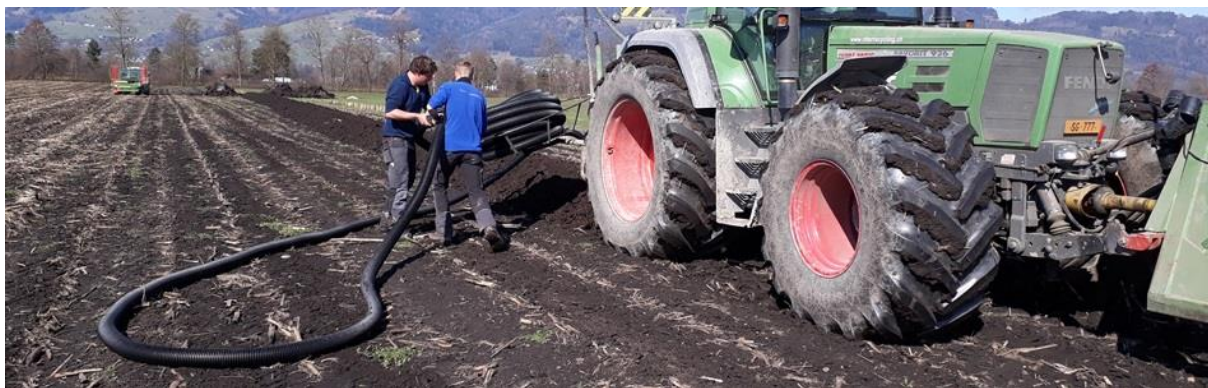
Abbildung 12: Mechanisierte Verlegung von Kunststoffrohren (Quelle: www.melioration-rheinebene.ch )
