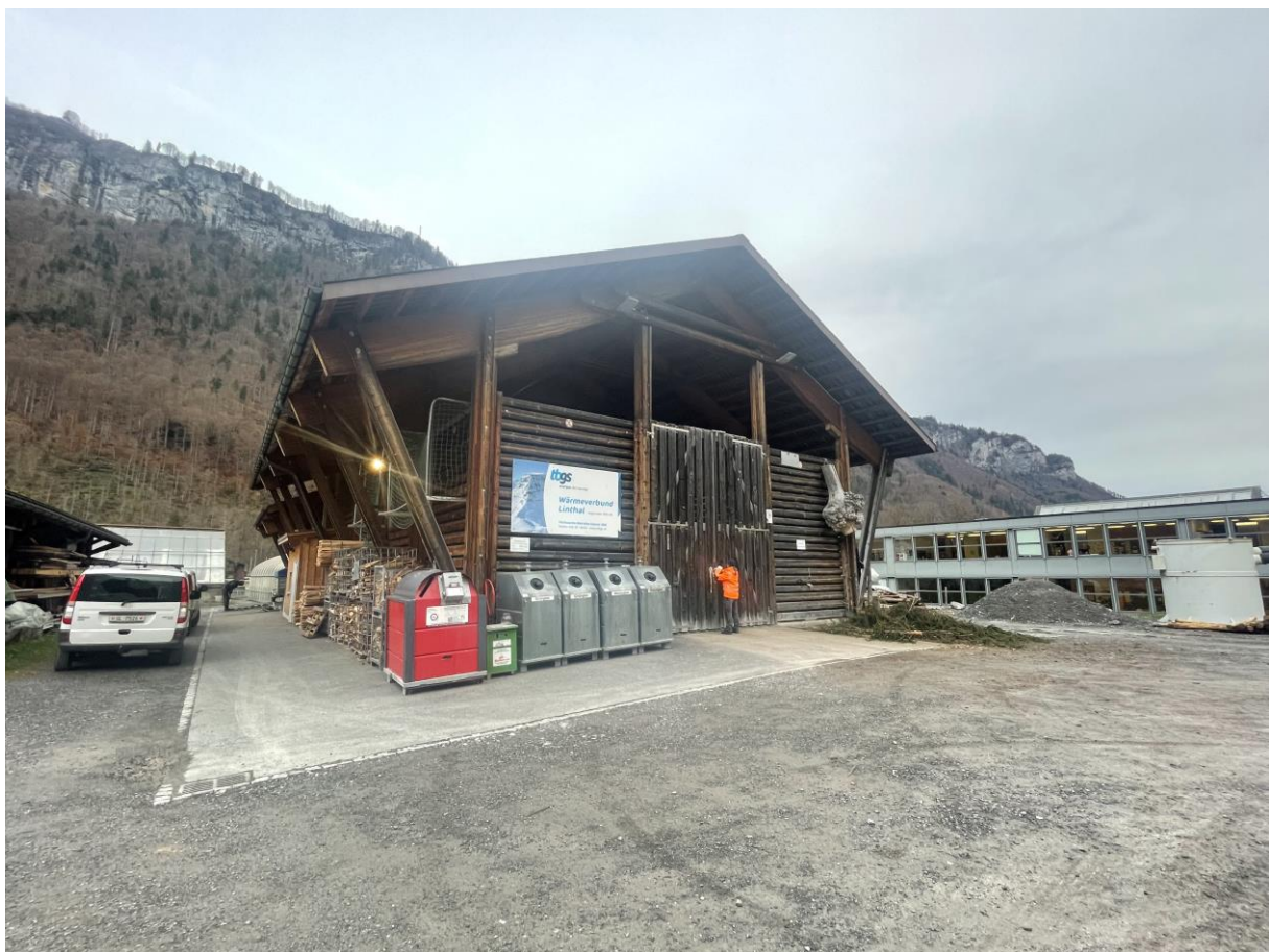
Bild 1: Heizzentrale des Wärmeverbands Linthal der Technischen Betriebe Glarus Süd.
