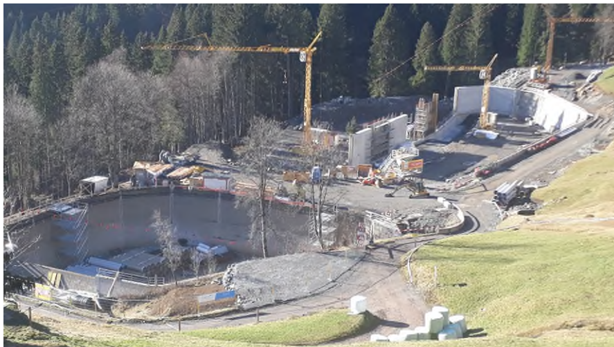
Bauarbeiten am Ausgleichsbecken des KW Luchsingerbach. Foto: J. Marti
