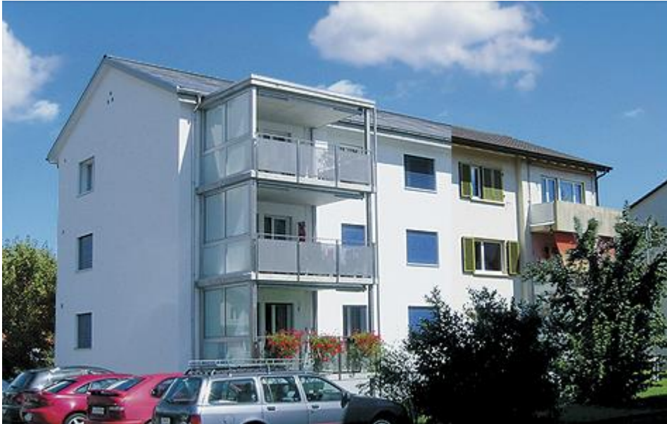
Bildlegende: MFH vor und nach der Sanierung
