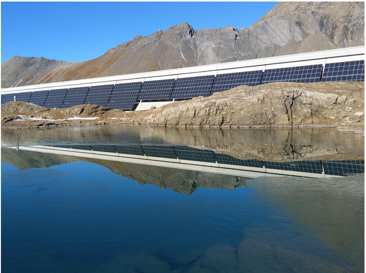
Grösste Photovoltaikanlage in Glarus Süd und im Kanton: Alpin Solar Mutensee, 2200 kW, Ende 2021 ca. 1900 kW
