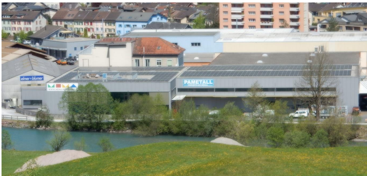
Grösste Photovoltaikanlage in Glarus: MEMA Metallbau AG, Ennenda, 200 kW
