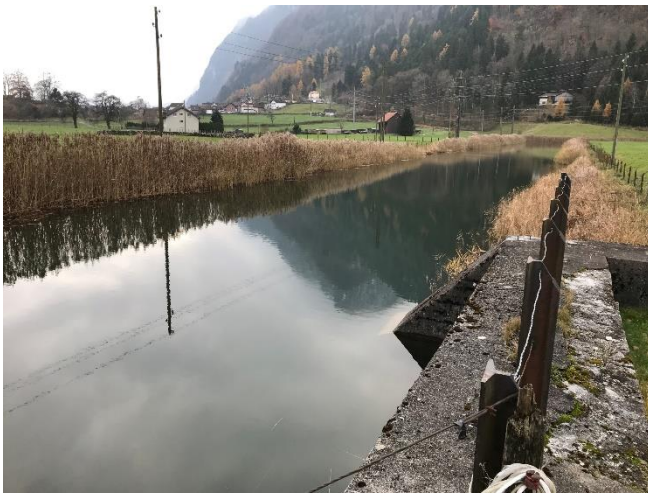
Fotografie des Tankgraben VII in Richtung Westen.
