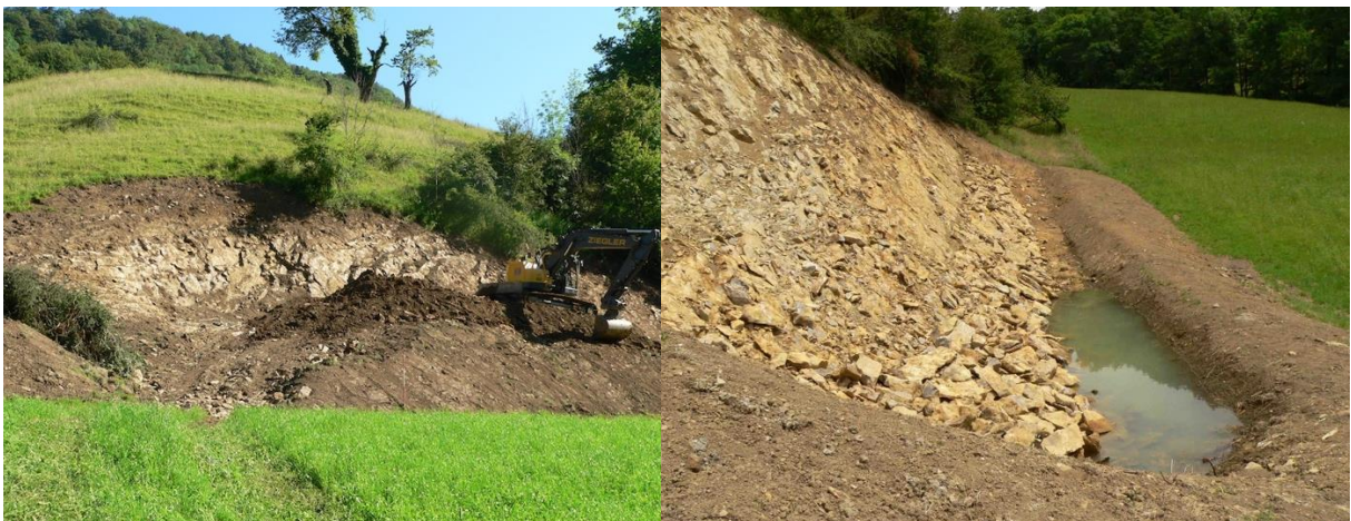
Abb. 12: Ersatzlebensraum für die Geburtshelferkröte. Links: während dem Bau. Rechts: fertig gestaltetes Biotop. Die frei gelegte Felswand aus Lias-Kalk bietet optimale Verstecke für die wärmebedürftige Art. Fotos: Barbara Schlup.
