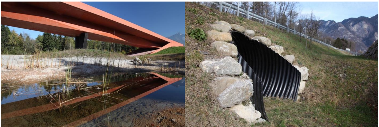
Abb. 14: Autostrasse H144 zwischen Rennaz (VD) und Les Evouettes (VS). Links: Tierpassage und Feuchtlebensräume bei Illes Ferrandes. Rechts: Unterführung für Kleintiere. Kanton Waadt – DGMR – H144. Photographie © Vanina Moreillon / Photoconstruction.
