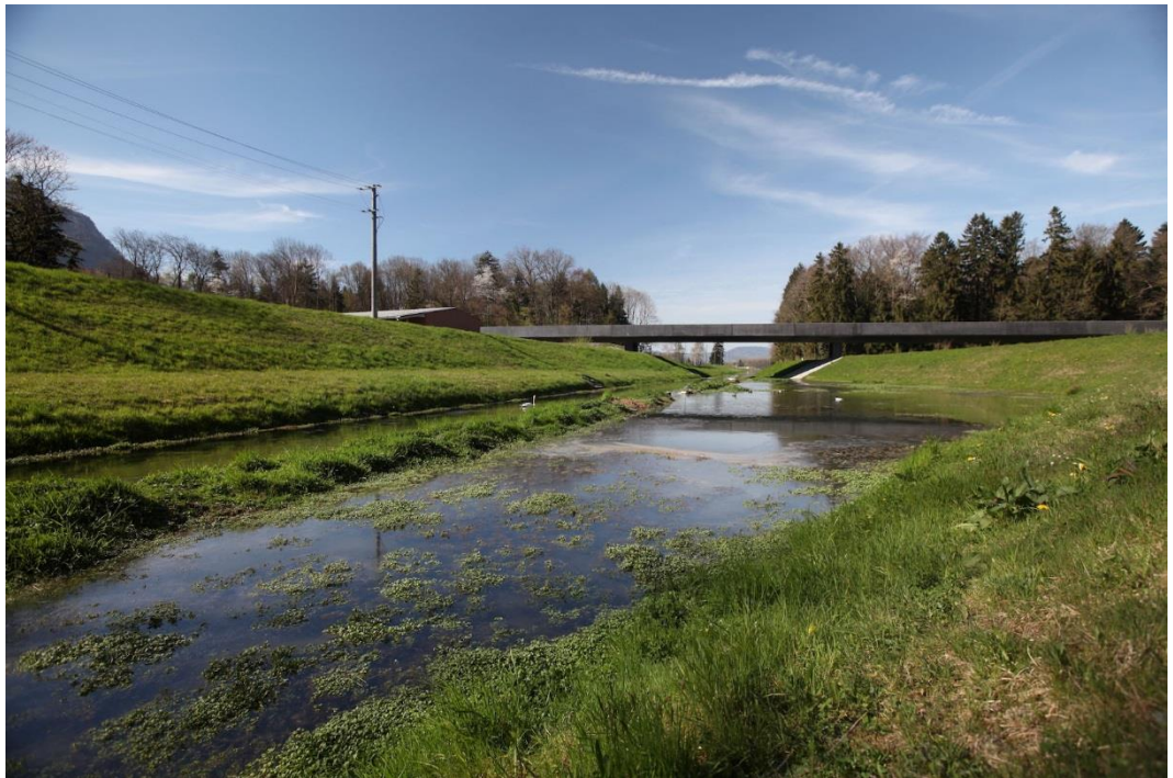
Abb. 15: Passage für kleine und mittelgrosse Tiere und Feuchtbiotop am Gran Canal bei Chessel (VD). Kanton Waadt – DGMR – H144. Photographie © Vanina Moreillon / Photoconstruction.
