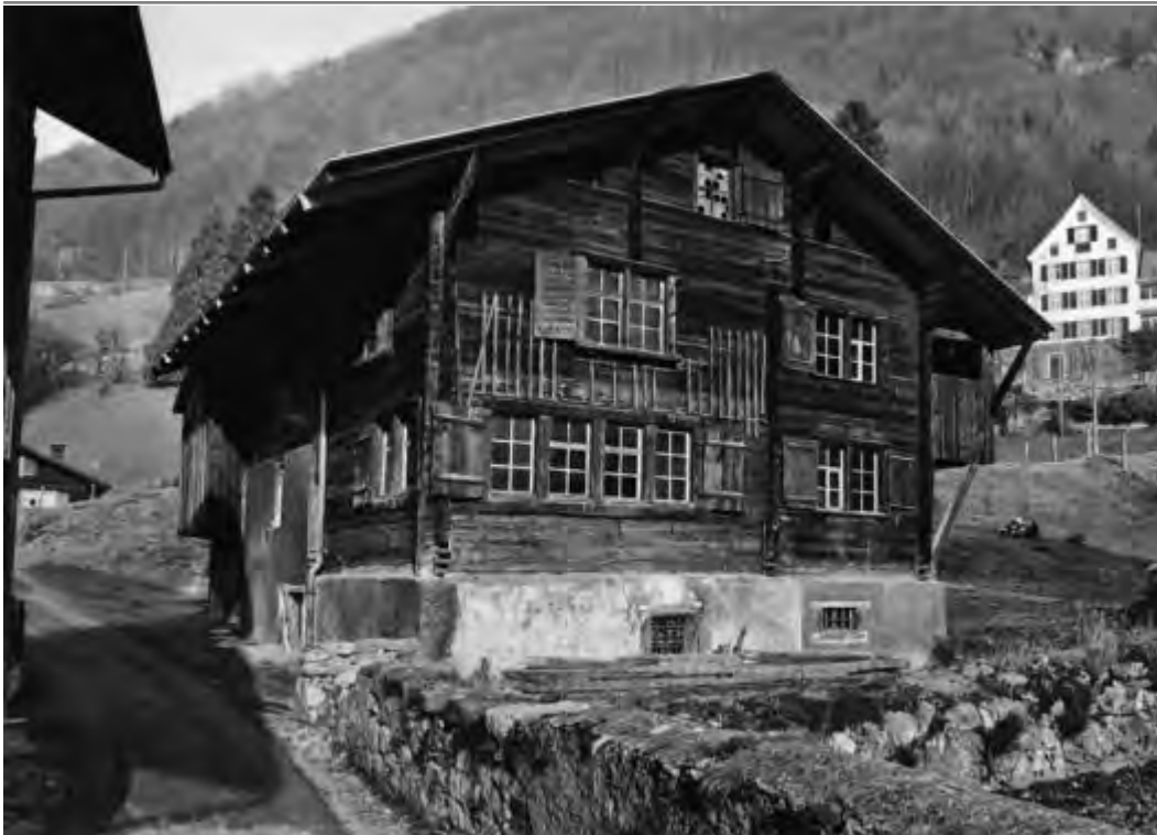
Mollis, Haltligasse 2. Rüfihaus im Hinterdorf von 1688. Südfassade vor der Restaurierung von 1973. Blockhaus auf einem gemauerten Kellersockel. Alte Fenstereinteilung, teilweise mit Butzenscheiben. Mit dem „Rain“ das älteste Haus des Hinterdorfs. Rechts der „Weinrain“ von 1720. (Bild: Fietz Schönwetter, um 1960. LAGL 84527/6//285)
