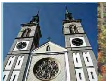
Stolzer Bau Die reformierte Stadtkirche von Glarus ist das Wahrzeichen der Gemeinde.
