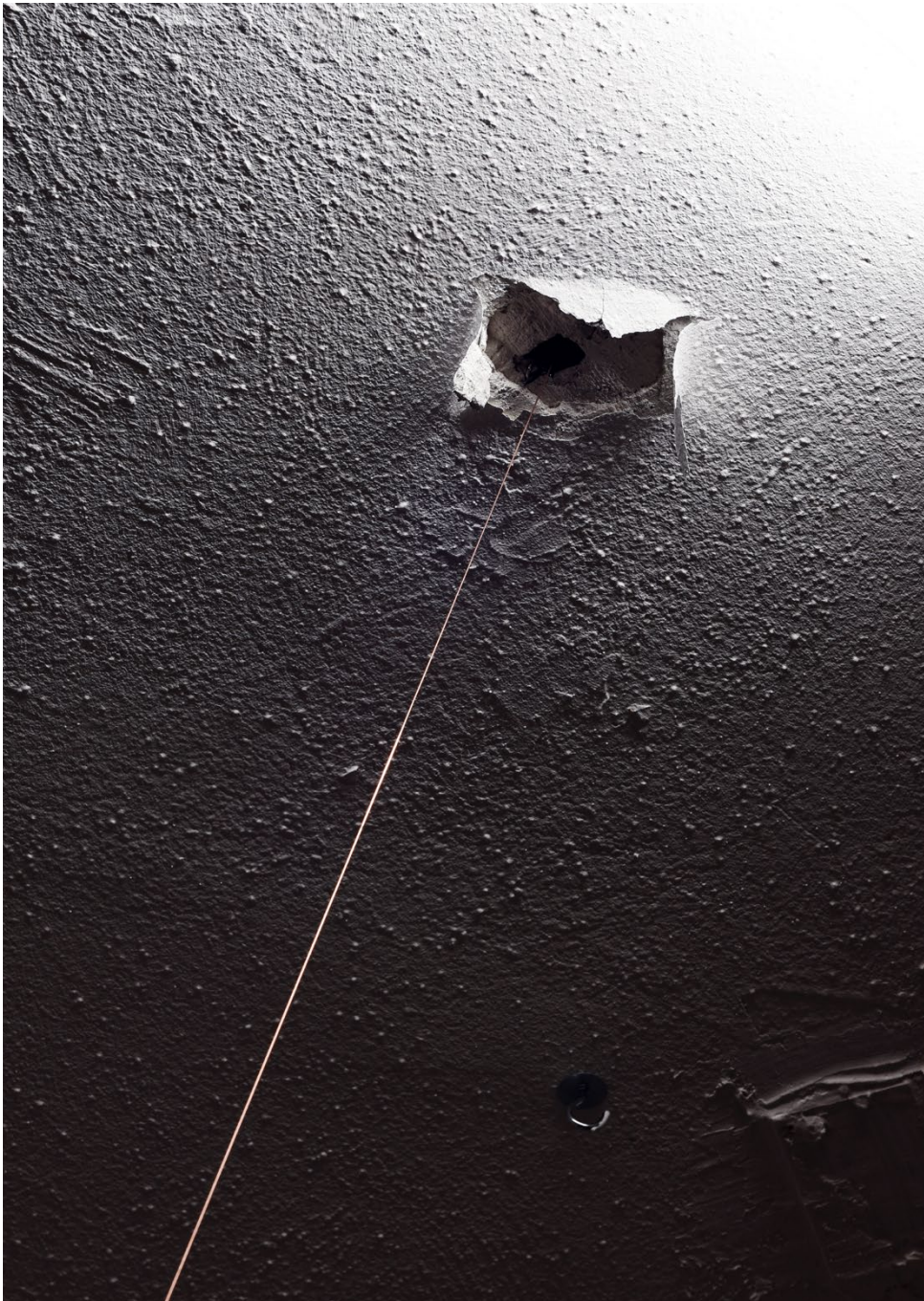
Detail eines Drahtes der durch ein Loch in der Decke in den überliegenden Raum gespannt wurde...
