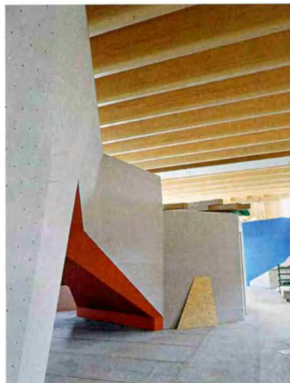
Rohbau der neuen Boulderhalle in Näfels. Foto: zvg
