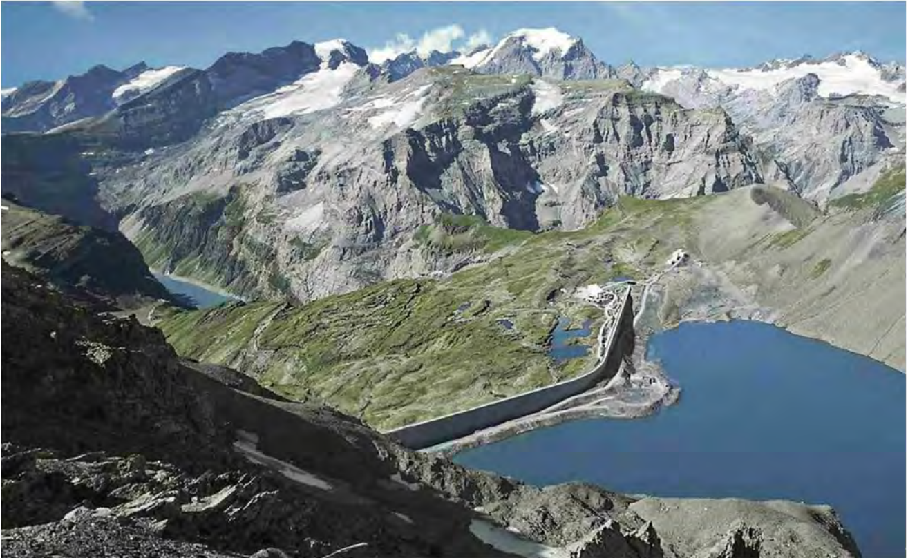
Längst ist der Stausee mit Wasser gefüllt, am Netz ist das Pumpspeicherkraftwerk Linth-Limmern wegen technischer Probleme aber noch nicht.
