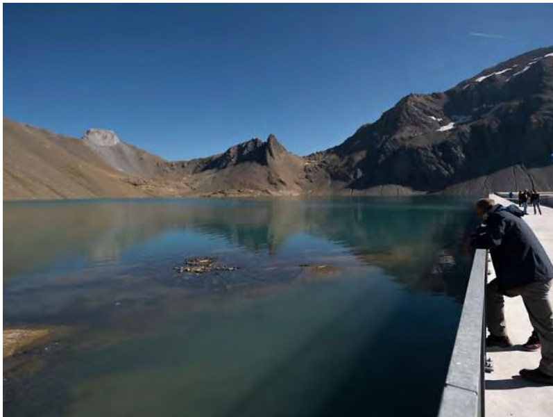
Blick auf den Muttsee des Pumpspeicherwerks Limmern der Axpo in Linth. Das Wasser gelangt in den tiefer gelegenen Limmernsee und wird auf dem Weg dorthin verstromt. KEYSTONE/GIAN EHRENZELLER
