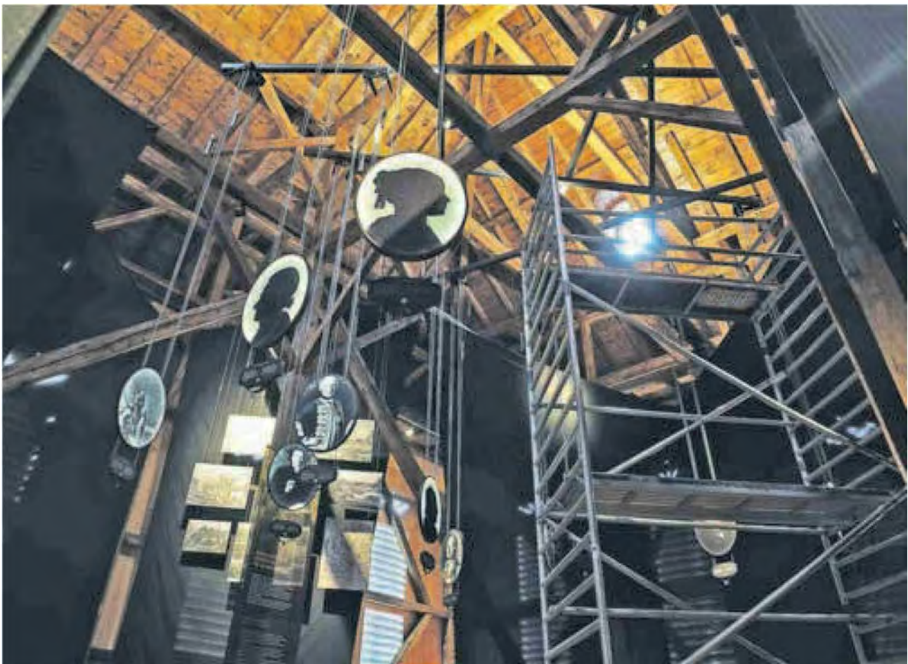
Baustelle: Bald werden die Baugerüste Vitrinen und Ausstellungsobjekten weichen.
