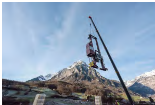
Westfalia: Einbringung des Regalbediengeräts ins Hochregallager. (Bild: zvg)
