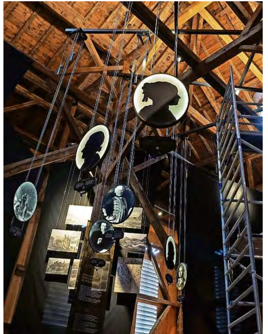
Baustelle: Bald werden die Baugerüste Vitrinen und Ausstellungsobjekten weichen.
