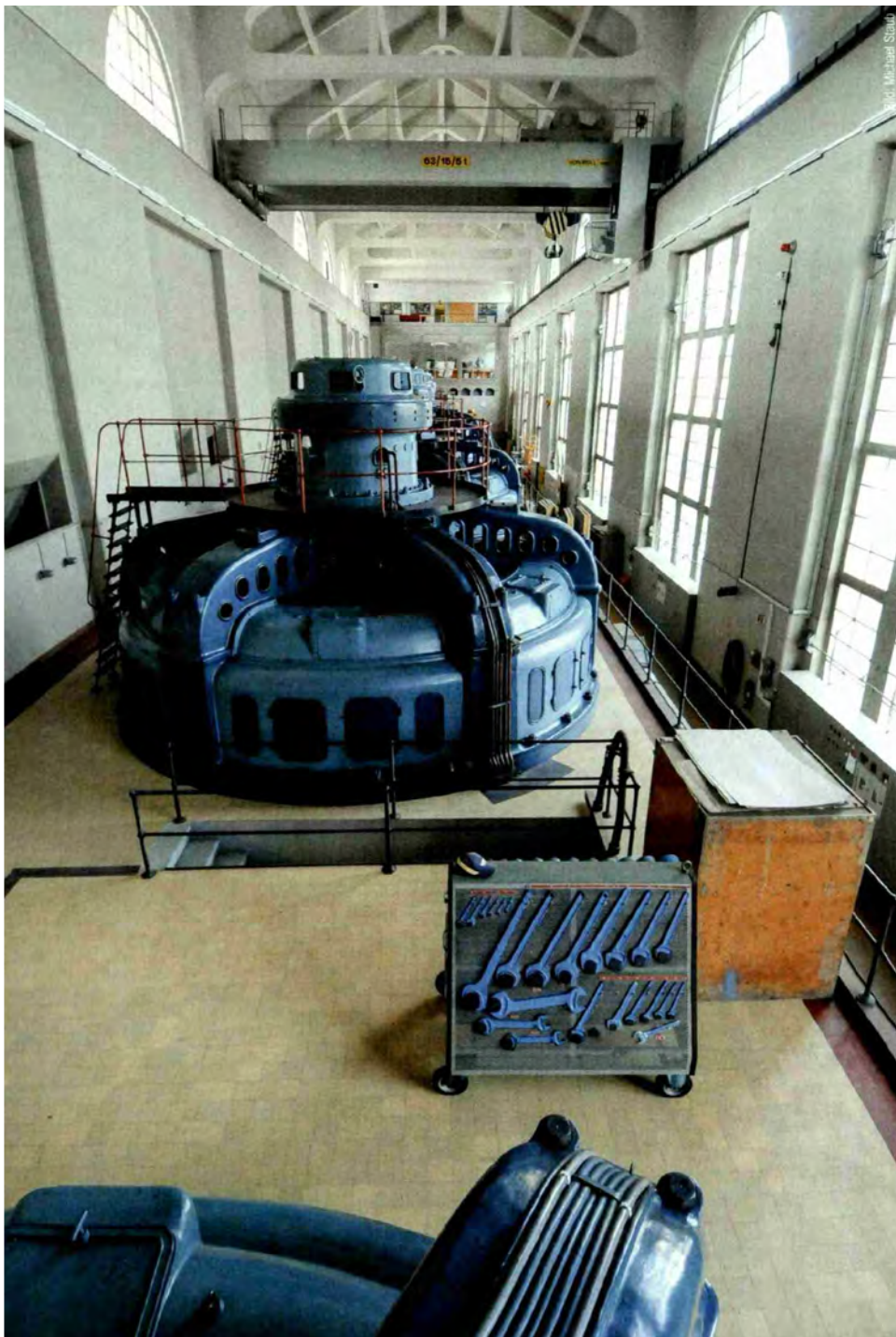
Blick ins Wasserkraftwerk Mühleberg: Mit Infrastrukturfonds könnten EVU solche Anlagen langfristig und ohne Eigenkapital-Einsatz finanzieren.
