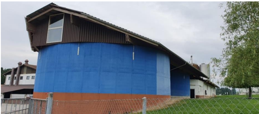
Abb. 3: Feste Konstruktion, individuelle Holzabdeckung oder Stahlkonstruktion. Im Bild zu sehen ist eine baubewilligungspflichtige Konstruktion mit Firsthöhe > 120 cm gemessen ab Silooberkante. Foto: Dienststelle uwe
