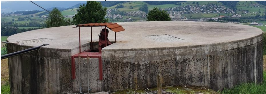
Abb. 5: Feste Konstruktion, Ortsbetondecke. Foto: Dienststelle uwe
