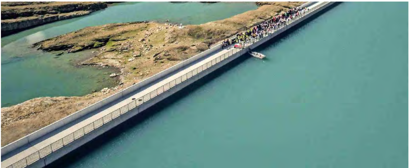
Investition in eine ungewisse Zukunft: Die Staumauer beim Muttsee des Pumpspeicherwerks Linth-Limmern bei ihrer Einsegnung im September 2016. Foto: Axpo/Keystone
