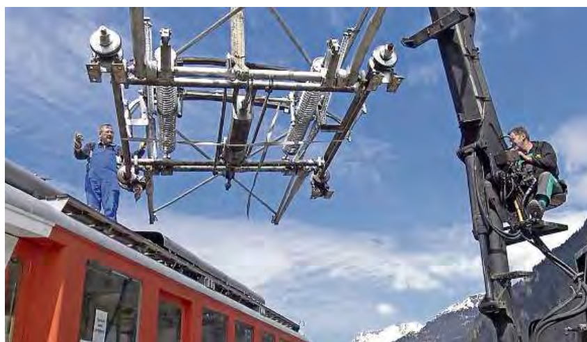
Geschenk der Rhätischen Bahn: Ein historischer Stromabnehmer der Berninabahn wird in Elm wieder montiert.
