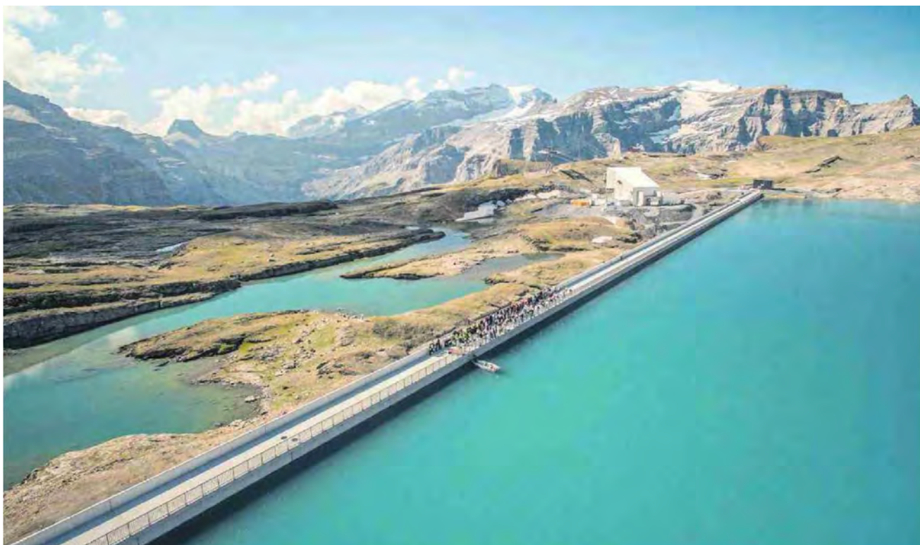
Die Staumauer Muttsa im Kanton Glarus. Sie ist ein zentrales Element des Pumpspeicher- Kraftwerks Limmern. (2016)
