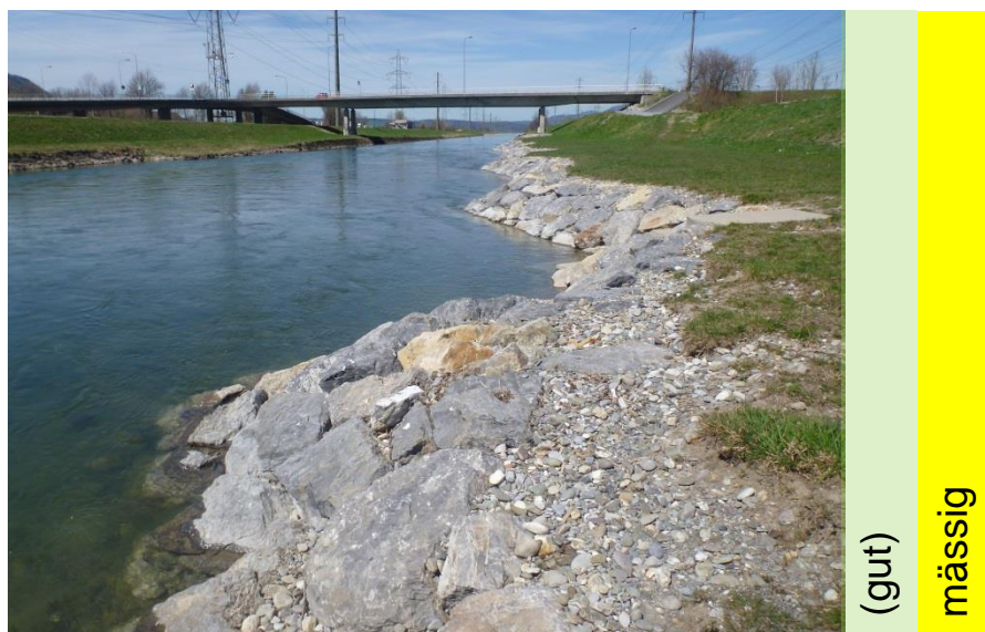
Abb. 25 Wellenförmiger Blocksatz oberhalb der Brücke Schänis rechtsufrig, Foto J. Guthruf.
