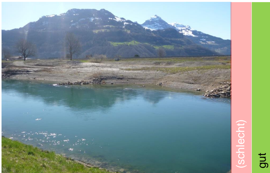
Abb. 28 Natur-Ufer mit Buhnen oberhalb Ziegelbrücke linksufrig, Foto J. Guthruf.
