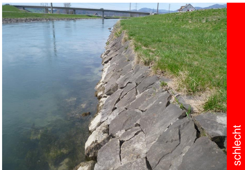
Abb. 19 Mit Blocksatz befestigtes Ufer rechtsufrig oberhalb Giessen, Foto J. Guthruf.
