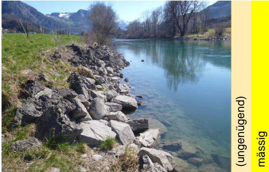
Abb. 22 Blockwurf-Verbauung oberhalb Ziegelbrücke rechtsufrig, Foto J. Guthruf.
