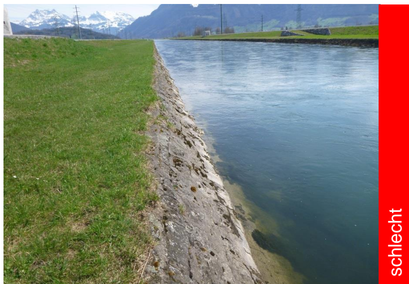
Abb. 18 Mit Mauerwerk befestigtes Ufer rechtsufrig oberhalb Grynau, Foto J. Guthruf.
