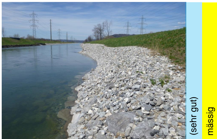
Abb. 26 Kiesschüttungen mit Buhnen unterhalb Schänis rechtsufrig, Foto J. Guthruf.
