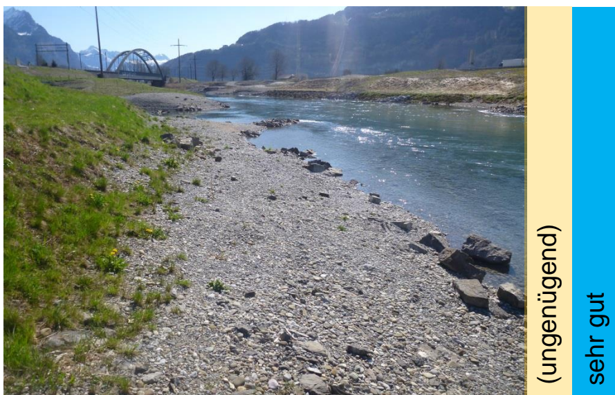
Abb. 29 Natur-Ufer mit Blockwurf oberhalb Ziegelbrücke rechtsufrig, Foto J. Guthruf.
