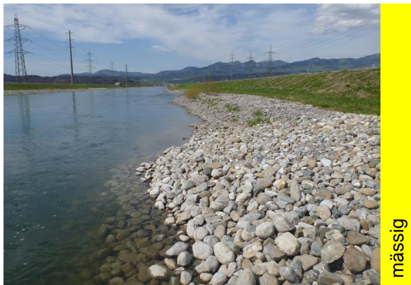
Abb. 24 Relativ steile Steinschüttung unterhalb Schänis rechtsufrig, Foto J. Guthruf.
