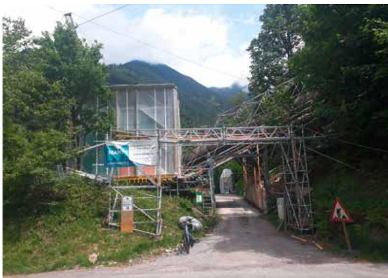
*Die Erneuerung des Korrosionsschutzes erfordert eine aufwändige Einrichtung (AUE).*
