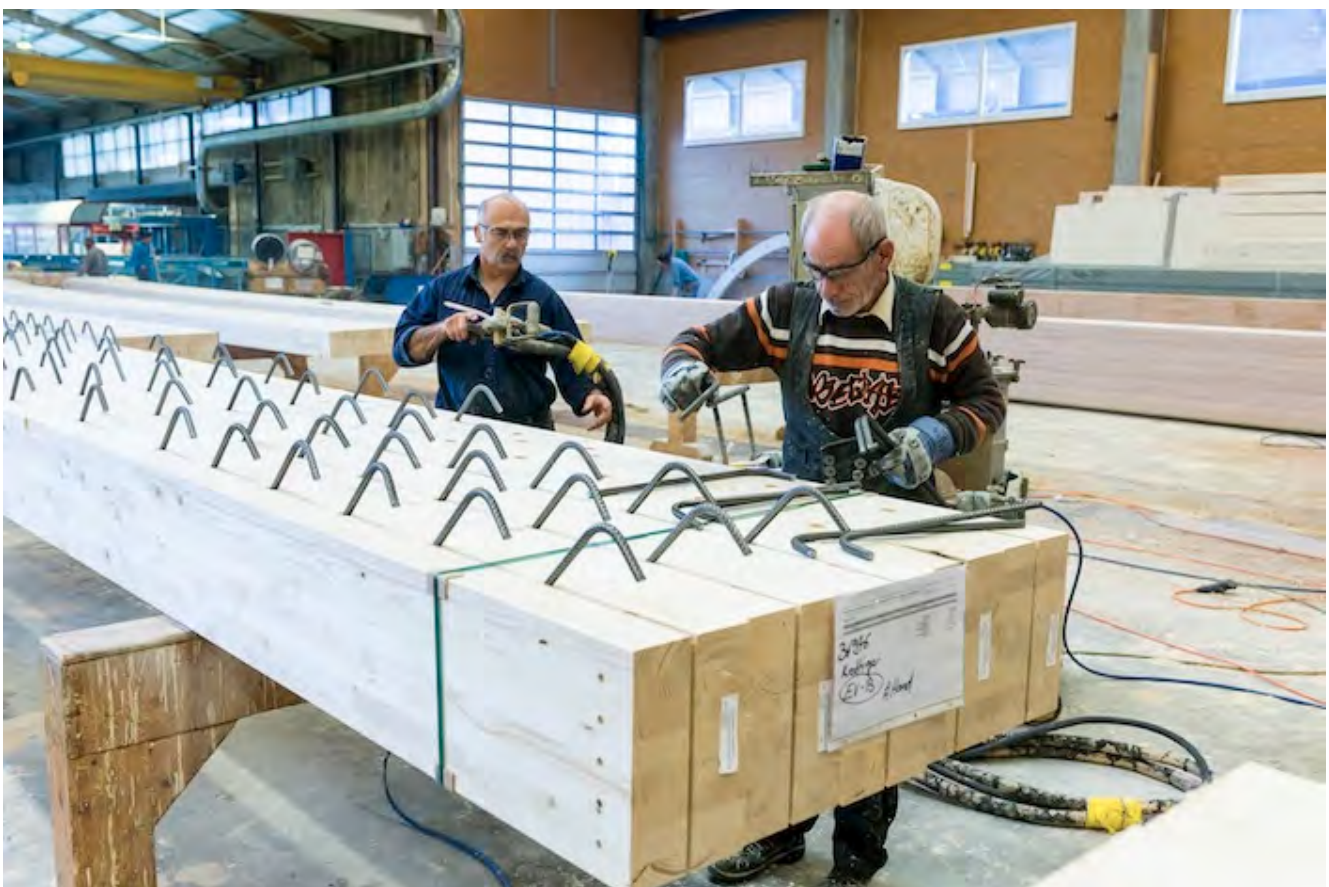
Schweres Geschütz: In den Hallen des Unternehmens werden gewichtige und sperrige Holzteile verarbeitet.
