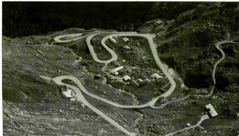
Die Klausenstrasse war der technisch anspruchsvollste Kunstbau im Alpenraum. Die Aufnahme aus dem Jahre 2014 zeigt die Einmündung der Militärstrasse in die Klausenstrasse bei Vorfrutt.
