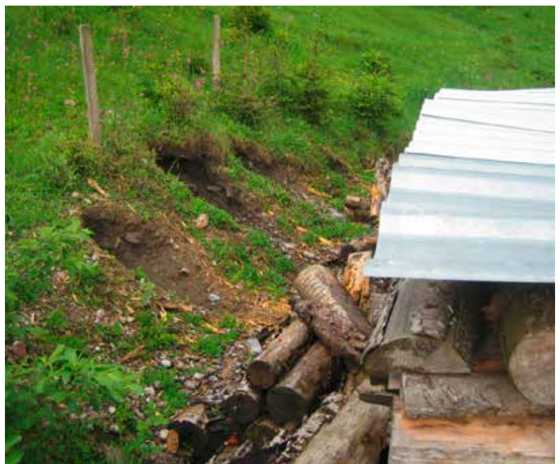
Schiessanlage Äschen vor der Sanierung (AUE).
