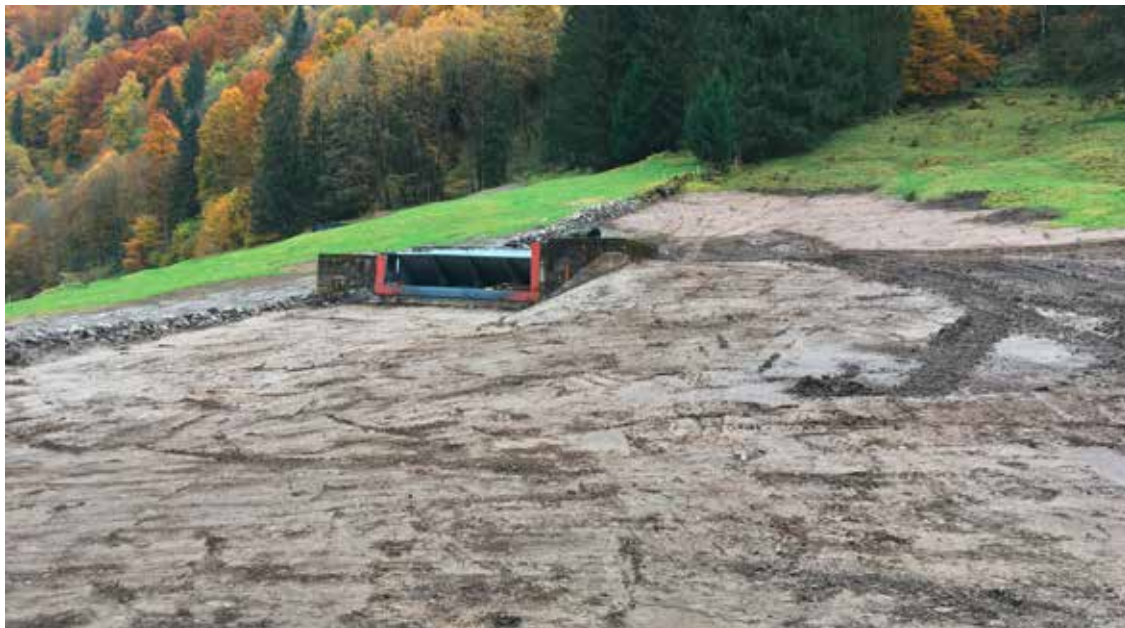
Schiesanlage Aesch während der Sanierungsarbeiten (AUE).
