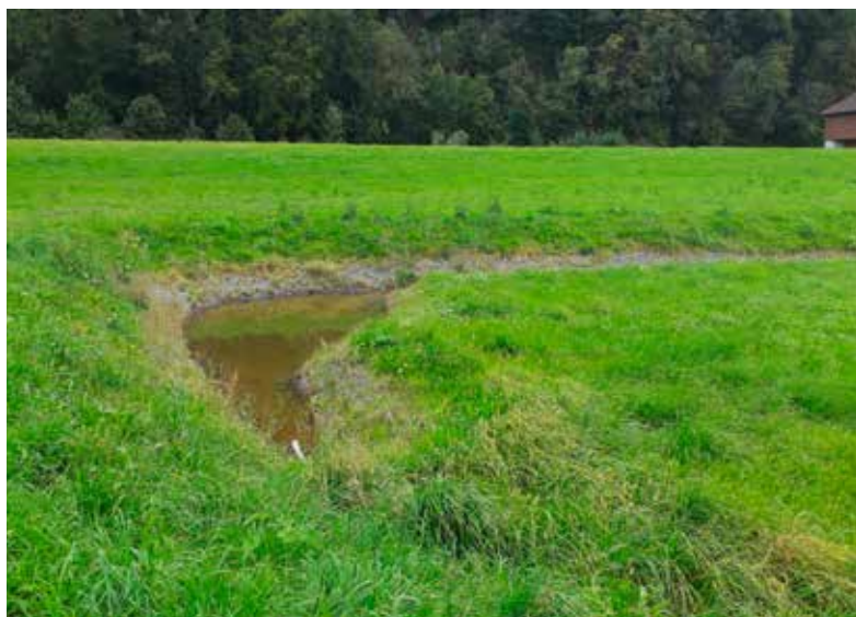
Beispiel einer Versickerungsmulde bei der Stichstrasse (AUE).
