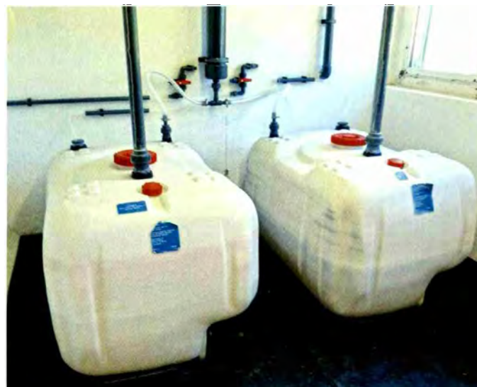
Javeltanks zur Desinfektion
