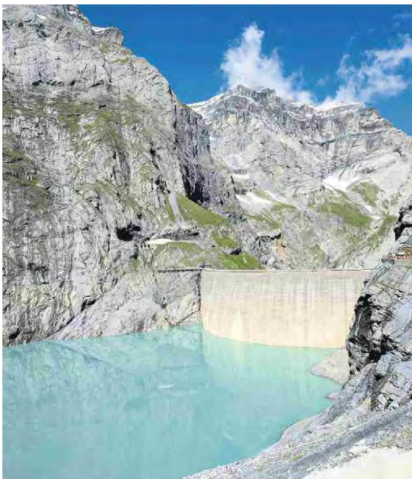
Die Staumauer am Limmernsee im Glarner Grosstal bei Tierfehd im Kanton Glarus.
