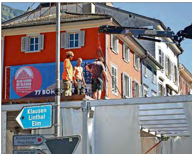
Eine kurze Verschnaufpause auf dem Dach gefällig?
