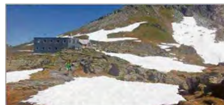
Die Leglerhütte: Moderner Neubau mit Aussicht über das Glarnerland. F.219.
