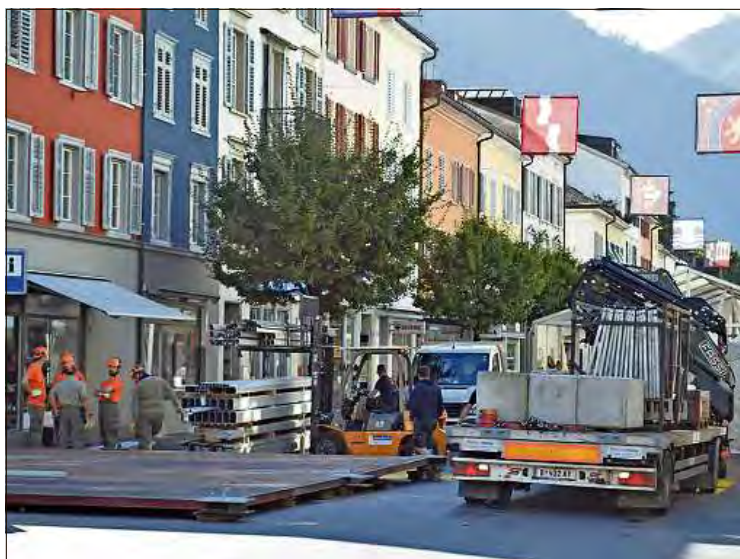
9.30 Uhr morgens. Das Aufbau-Team beginnt mit der schweisstreibenden Montage.
