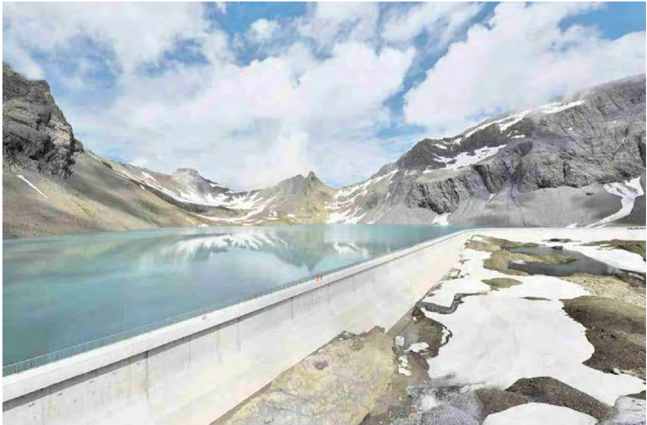
Anfang August 2016 erstmals voll: Die neue Staumauer vergrössert den Mutsee auf das Dreifache.
