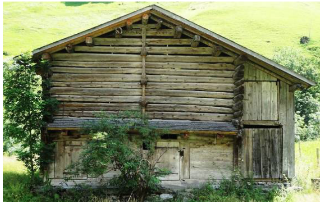
Abb. 172: Elm Obmoos, datiert 1687. Giebelständig, eine Blockzange mit dreifachem Bohlen-schluss. Steht auf gemauerten Sockel. EG ganz in Kantholzblock-technik, OG gekatzt. Einseitig angebaut. Rückwärtiger Eingang zum Heuboden. Enge Pfettenlage.
