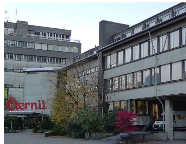
Abb. 112: Niederurnen, Eternit AG, Verwaltungsgebäude. Von Haefeli/Moser/Steiger 1945-55 entworfen.
