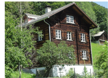
Abb. 44: Elm, Staldenstrasse, vor 1900. Blockbau in der Bautradition des 18. Jahrhunderts, mit zeitgenössischer Raumaufteilung, Dach- und Fensterformen.
