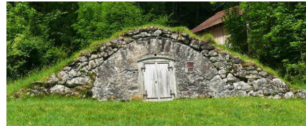
Abb. 195: Schwanden, Thon, Ennedeggen: Wasserreservoir.
