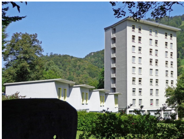
Abb. 73: Glarus, Kantonsspital. Personalwohnhäuser von J. Zweifel, 1953.
