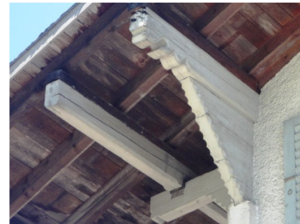
Abb. 51: Rüti, Dorfstrasse 51/53, um 1700. Gekerbte Pfettenkonsole, darüber ein sog. Drachenkopf als Pfettenkopf. Flugpfette und Flugrafen ermöglichen den grossen Dachüberstand.
