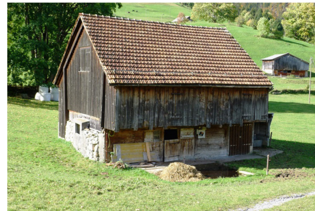
Abb. 165: Obstalden, Hüttenberg 11. Traufständiger Gaden mit teilweise gemauertem Sockel
