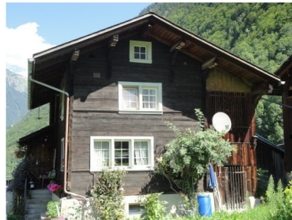
Abb. 31: Matt, Auen, vor 1730. Einraumbreites Haus mit angebauter Klein-Ökonomie und breitem Dachvorstand. Die verzierten Pfetten enthalten hier keine datierenden Elemente.
