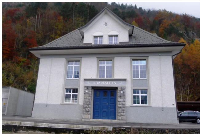
Abb. 137: Näfels, Elektrizitätswerk der Gemeinde am Löntsch.
