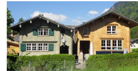
Abb. 47: Rüti, Dorf. Links: Fensterfront und Schindelschirm von 1892. Rechts: neu eingeschnittene und damit zerstörte Fenstersituation, neuer Schindelschirm.
