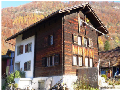
Abb. 30: Mollis, Haus Seelmess, 1768. Rekonstruierte Fassade. Auch bei Kleinhäusern setzen sich das gemauerte Feuerhaus und der Kachelofen ab etwa 1650 durch.
