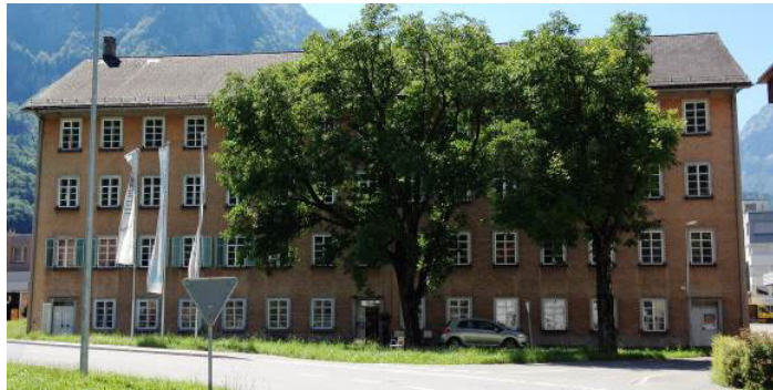
Abb. 125: Ennenda, Trümpiger. Druckereigebäude, später Kontor der Firma Daniel Jenny & Cie. von 1854.
