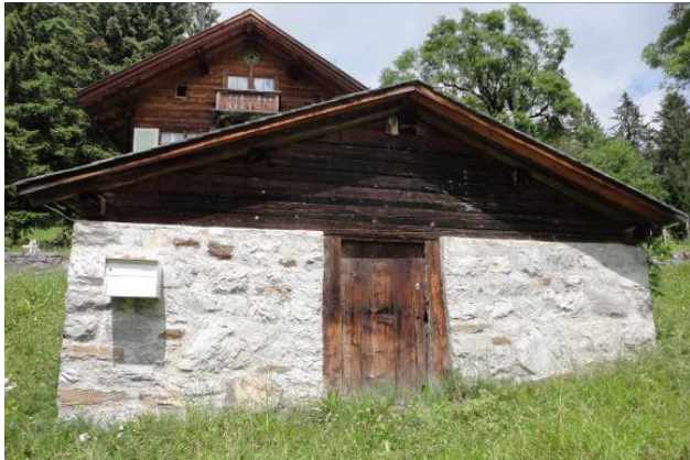
Abb. 199: Braunwald, Führl. Über dem gemauerten Sockelgeschoss ein Balkengefüge.
