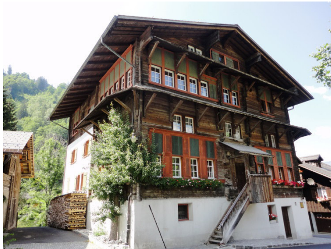
Abb. 17: Elm, Grosshaus, um 1550, nach 1600 aufgestockt und mit Klebdächern ergänzt.
