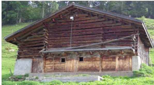
Abb. 167: Ennenda, Hinterer Ennetberg. Giebelständiger Gaden mit beidseitiger Erweiterung des Heubodens im Obergeschoss. Im Erdgeschoss giebelseitig Block, traufseitig gemauert; eine jüngere Blockzange.
