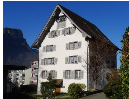
Abb. 35: Mollis, Neuhaus 1746/48. Hinterhaus gemauert, südseitig Block unter Verputz. Steilgiebel mit geknickter Dachfläche (Pfettensparrendach) mit Flugrafen.
