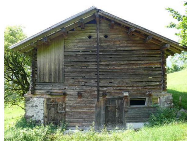
Abb. 171: Diesbach, Schluchen. Kleiner Doppelstall, für zwei Parteien, ohne Zugäden.
