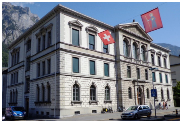
Abb. 104: Glarus, Altes Stadtschulhaus 1872.
