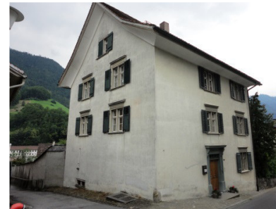
Abb. 43: Mitlödi, Dorf 1825. Traditionelle Proportionen mit Steilgiebel, dafür verputzter Dachunterzug und Fensterverdachung
