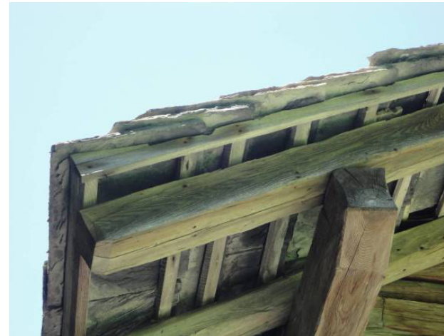
Abb. 181: Matt, Auen. Frei liegendes Schieferplattendach.
