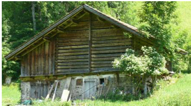
Abb. 170: Hätzingen, Waldstrasse/Loo. Giebelständiger Gaden, einseitig angebaut mit einfacher Blockzange. EG gemauert, OG mit lockerem Block. Regelmässige Pfettenlage.
