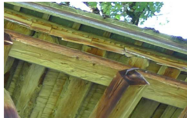
Abb. 182: Näfelsberg, Twing: Unterdach aus Legeschindeln und Überdachung aus Eternit..
