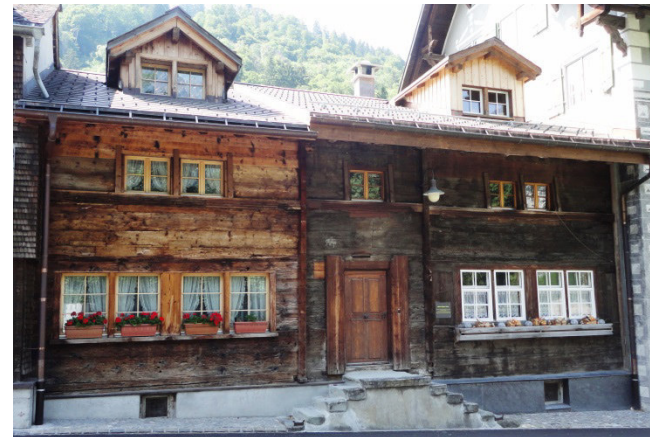
Abb. 6: Elm, Ulrich-Elmer-Haus. Ständerbohlenbau mit Mittelquergang, datiert 1427.
