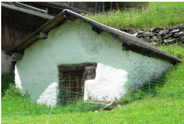
Abb. 200: Elm, Steinibach. Milch- und Käsespeicher
