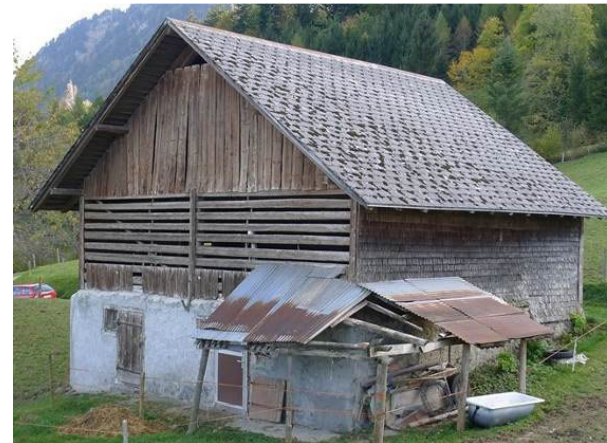
Abb. 174: Bilten Hämmerliberg. Das Erdgeschoss ist vollständig gemauert; wetterseitig wurde ein Schindelschirm angebracht.
