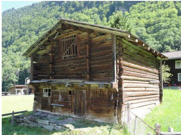
Abb. 178: Matt, Auen. Giebelständige Stallscheune mit zwei Blockzangen und dreifachem Bohlenschloss. Im Erdgeschoss Kant-holzblock giebelseitig, behauene Rundhölzer traufseitig. Wohl 16./17. Jh.
