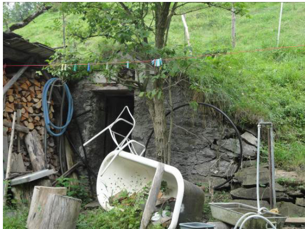
Abb. 197: Matt, Weid. Erdkeller, in den Hang hinein gegraben.
