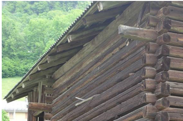
Abb. 183: Leuggelbach, Dorf. Verlängerter Balken als Ablage für Dachlatten. Neue Wellblechdeckung auf alten Rafer.
