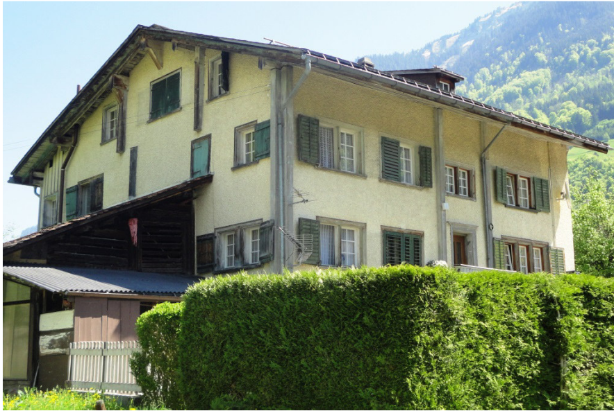
Abb. 15: Linthal, Hauptstrasse. Städtisches Mittelquerganghaus des 17. Jh. mit drei Längs- und Querzonen. Der typologische Reichtum des Blockbaus wurde im Glarnerland später nicht mehr erreicht.
