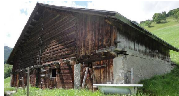
Abb. 173: Elm Berg: Breiter giebelorientierter Doppelgaden mit unterteiltem EG und Stallteil. Regelmässige, enge Pfettenlage. EG giebelseitig mit Block, Rest gemauert.
