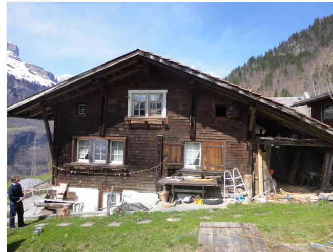
Abb. 55: Linthal Auen, Trümpis, 1752. Die zweiraumtiefen Berghäuser verfügen nur über ein Vollgeschoss und über eine Dachkammer. Der Zugang erfolgt in der Regel traufseitig, die Orientierung ist normalerweise giebelständig zum Hang.
