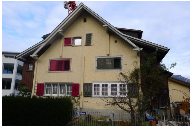
Abb. 49: Niederurnen, Bogenstrasse. Die beidseitigen raumhohen Lauben sind durch Aufschieblinge des Sparrendaches gedeckt.
