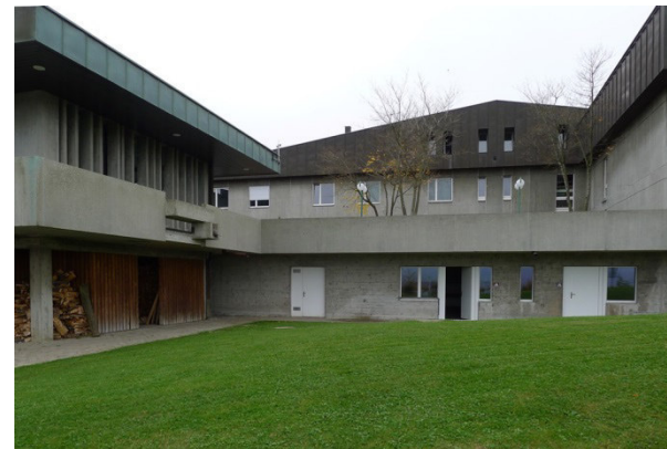
Abb. 75: Filzbach, Sportzentrum Kerenzerberg. 1973 durch Hans Oetiker im Auftrag des Kantons Zürich erstellt.
