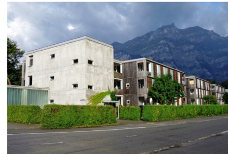
Abb. 81: Glarus, Alterssiedlung Volksgarten. Die Siedlung mit 32 Wohnungen, 1997 von Zimmermann-Architekten Aarau erstellt.
