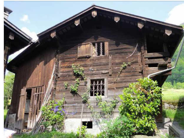
Abb. 198: Diesbach, Oberdorf. Zigerspeicher. Der Kantholzblock ist bis ins erste Obergeschoss durchgehend. Türe und Treppe sind bauzeitlich (17. Jh.)
