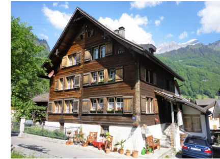
Abb. 34: Hätzingen, Haslerstrasse 3/5, nach 1800. Doppelwohnhaus als Blockbau mit Sparrendach.
