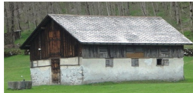
Abb. 188: Linthal, Ennetlinth, Allmendgaden. Erdgeschoss gemauert, Obergeschoss als Ständerkonstruktion.
