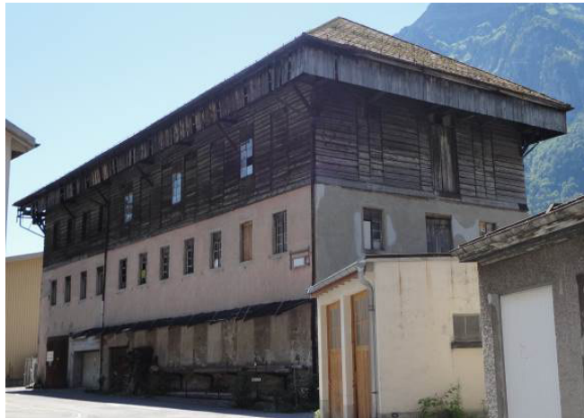
Abb. 130: Ennenda, Ennetbüels, Tschachen, 1865.
