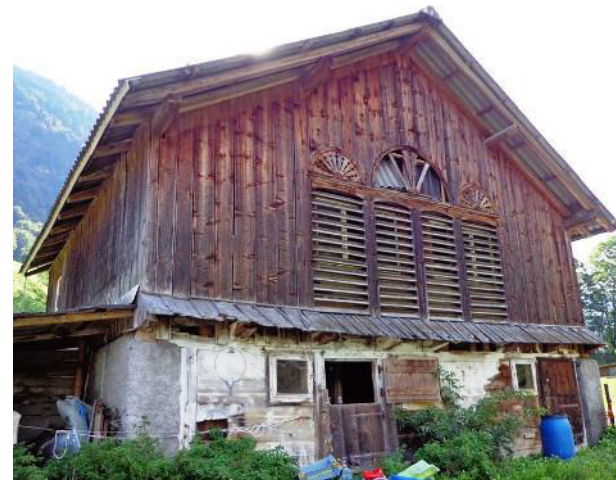
Abb. 177: Matt, Hinterer Stalden. Ständerkonstruktion mit Bretterverschalung und modernem Innenausbau.
