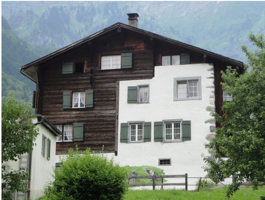
Abb. 1: Schwanden, Thon, Turähus. Der mittelalterliche Bau wurde im 1561 in einen repräsentativen Blockbau integriert. Gemauerter Kern, ev. um 1300. Mittelalterliche Kernbauten verstecken sich oft hinter unscheinbaren, später veränderten Fassaden oder wurden mit weiteren Bauteilen später gemeinsam überdacht.
