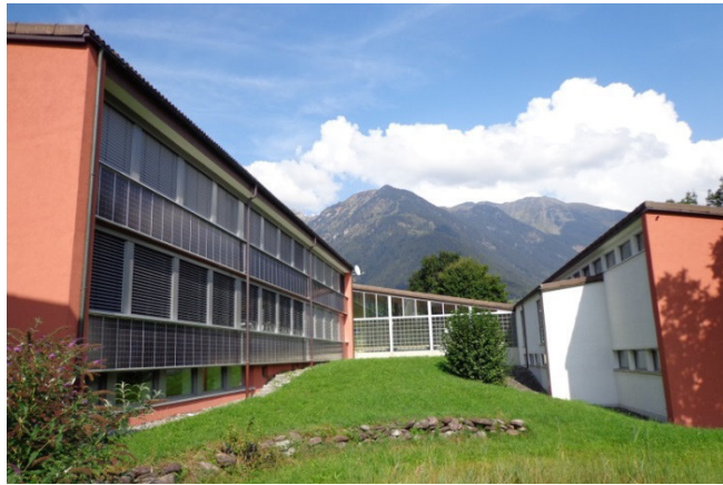
Abb. 103: Schwanden, Schulhaus Buchen.
