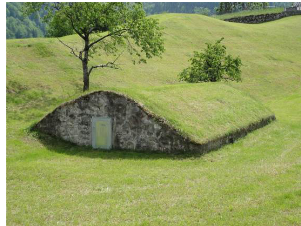
Abb. 196: Sool. Unterdorf. Lösch- wasserspeicher.
