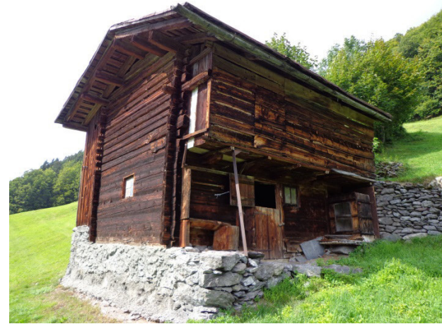
Abb. 168: Engi, Gufel. Seltenes Beispiel eines trauforientierten Stalls am Hang. Steht auf gemauertem Sockel, sonst rundum sauberer Block in EG und OG. Traufseitige Laube.
