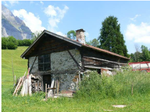
Abb. 194: Schwanden, Thon, Täniberg, Senn- hütte mit Innen- ausstattung. Gie- belseitige Bruch- steinausfachung der Ständerkon- struktion; traufsei- tige Bretterver- schalung.
