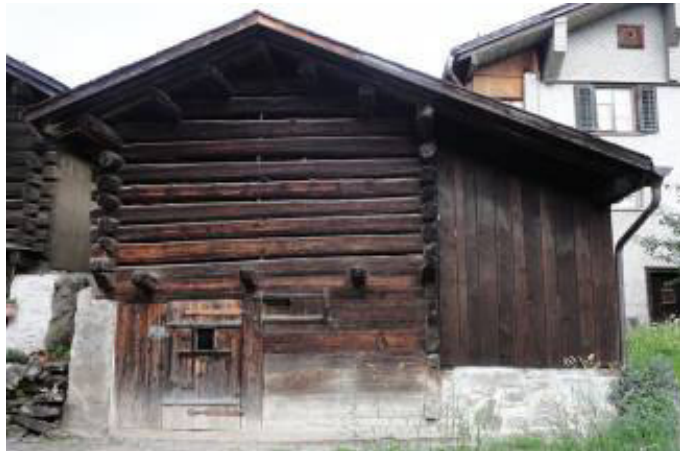
Abb. 152: Diesbach, Oberdorf. Kleinviehstall, einseitig angebaut. Giebelfront im Erdgeschoss mit Block, traufseitig gemauert. Obergeschoss lockerer Block.
