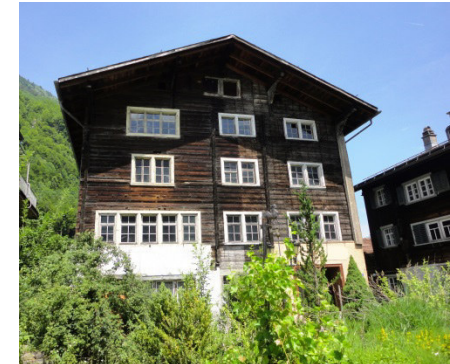
Abb. 28: Nidfurn, Hauptstrasse, Foto von 2012: Viergeschossiger Blockbau auf massivem Erdgeschoss, mit Mittellängsgang und westseitiger Laube. Die Beschreibung erfolgt heute nach funktionalen Kriterien und nicht mehr nach ethnologischen Merkmalen.
