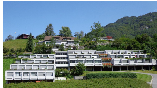
Abb. 74: Glarus, Sonnenhügel. Terrassenhäuser von J. Zweifel für das Spitalpersonal, 1968.
