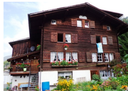
Abb. 36: Engi, Sändli, 1825. Die Brüder Oswald und Jakob Baumgartner errichteten das Doppelwohnhaus gemeinsam (Inchrift am First auf weisser Plakette). Die Bauweise als Doppelhaus tritt durch den verdeckten Binnenlängsstoss in den Hintergrund.
