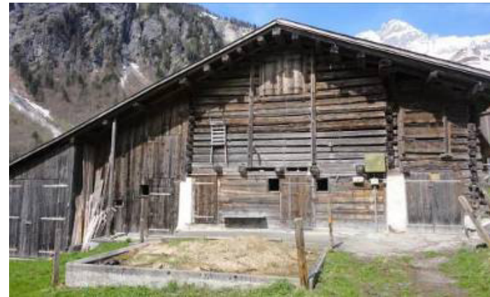
Abb. 151: Linthal Auen, Reitschachen. Giebelständige Stallscheune mit doppelter Blockzange, beidseitig angebaut mit eng liegenden Pfetten.
