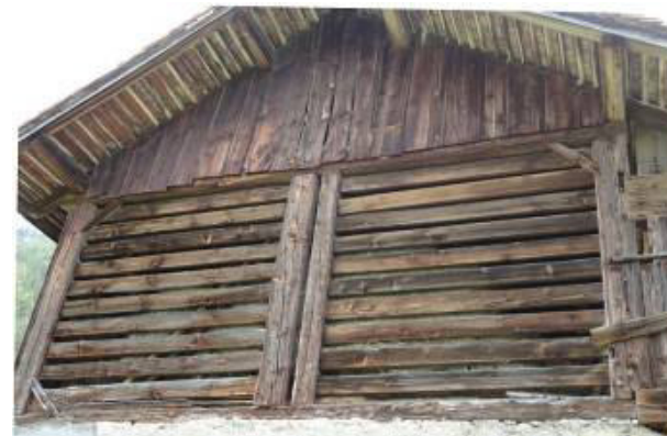
Abb. 176: Ennetbüels, Ennetbüels. Ständerkonstruktion mit eingelegten Querbalken.
