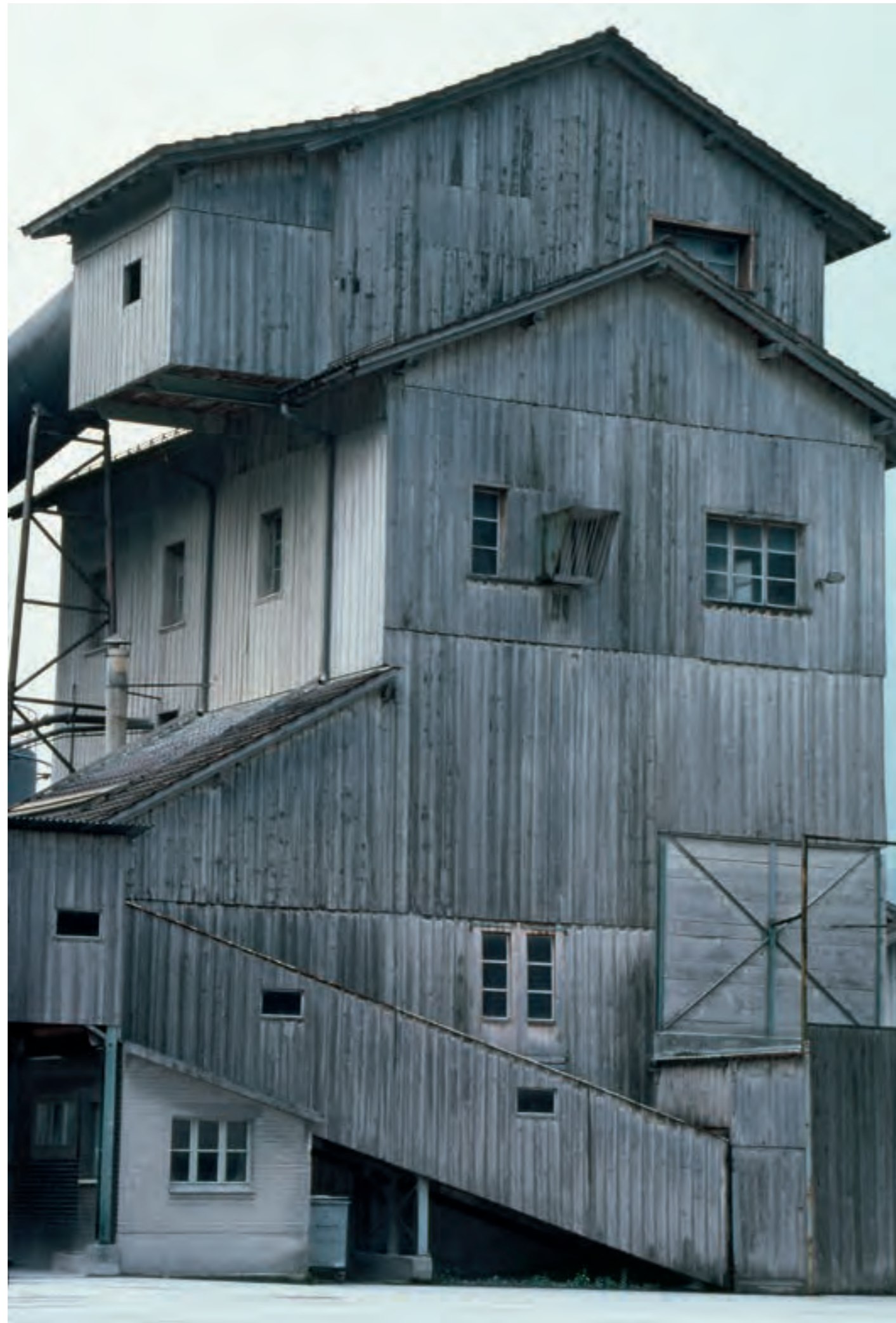
Ehemalige Kalkfabrik in Netstal.
