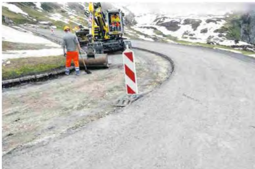
Die Klausen-Paspstrasse erhält im Bereich Obere Balm einen neuen Deckbelag.
