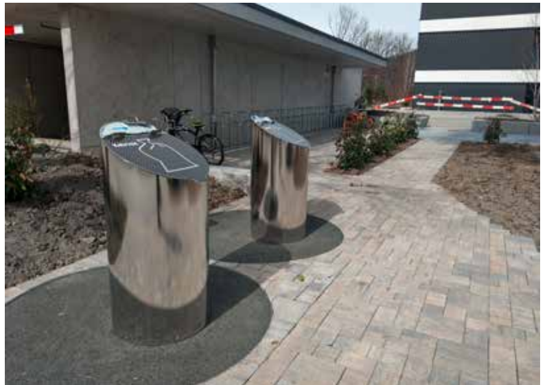
Der Zweckverband Abfallentsorgung Glarnerland hat auch Vorgaben für Unterflursammelstellen erlassen, damit diese im ganzen Kanton effizient entleert werden können (AUE).
