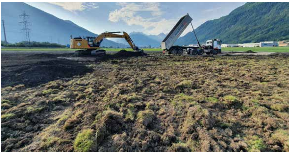
Die aufgelockerte Pilotfläche darf von den LKWs nur über die Baggermatratzen befahren werden (AUE).
