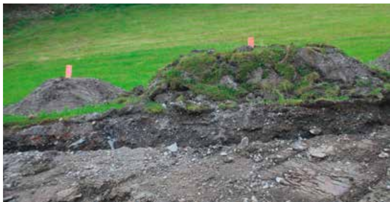
Dem Bodenschutz wird grosse Aufmerksamkeit geschenkt. Der anfallende Ober (A)- und Unterboden (B) wird getrennt gelagert. (AUE)
