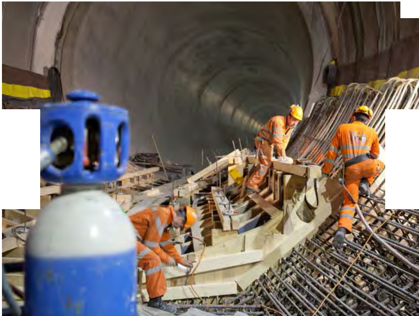
1/4 Die 1051 Meter langen Druckschächte werden mit dicken Stahlrohren ausgekleidet. SRF / MICHAEL BREU
