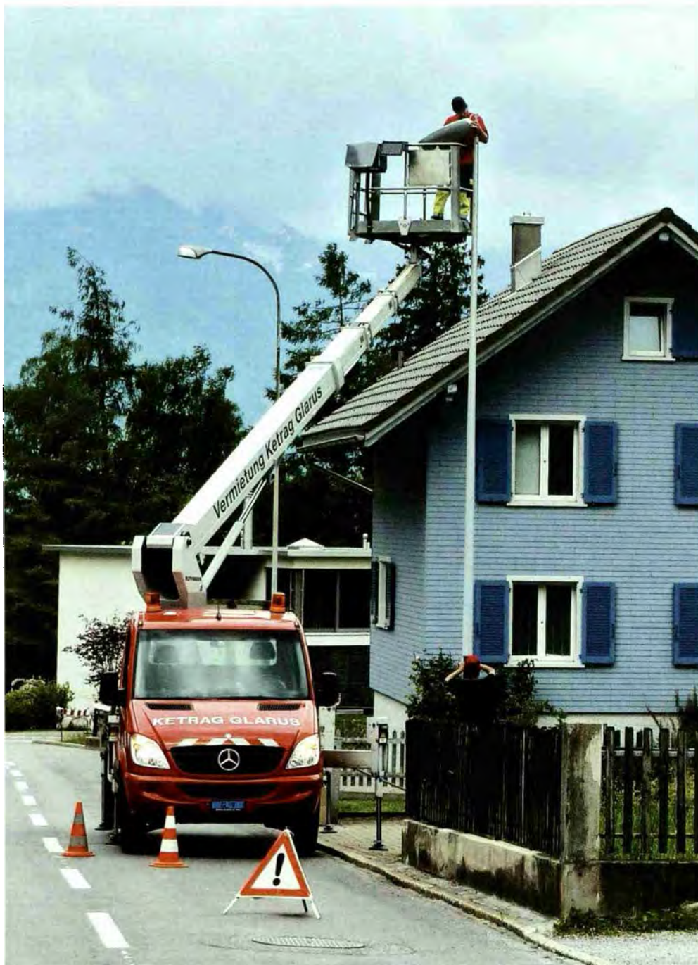
Monteure ersetzen die alten Quecksilberdampf Lampen in den Glarner Gemeinden durch moderne LED-Leuchten.
