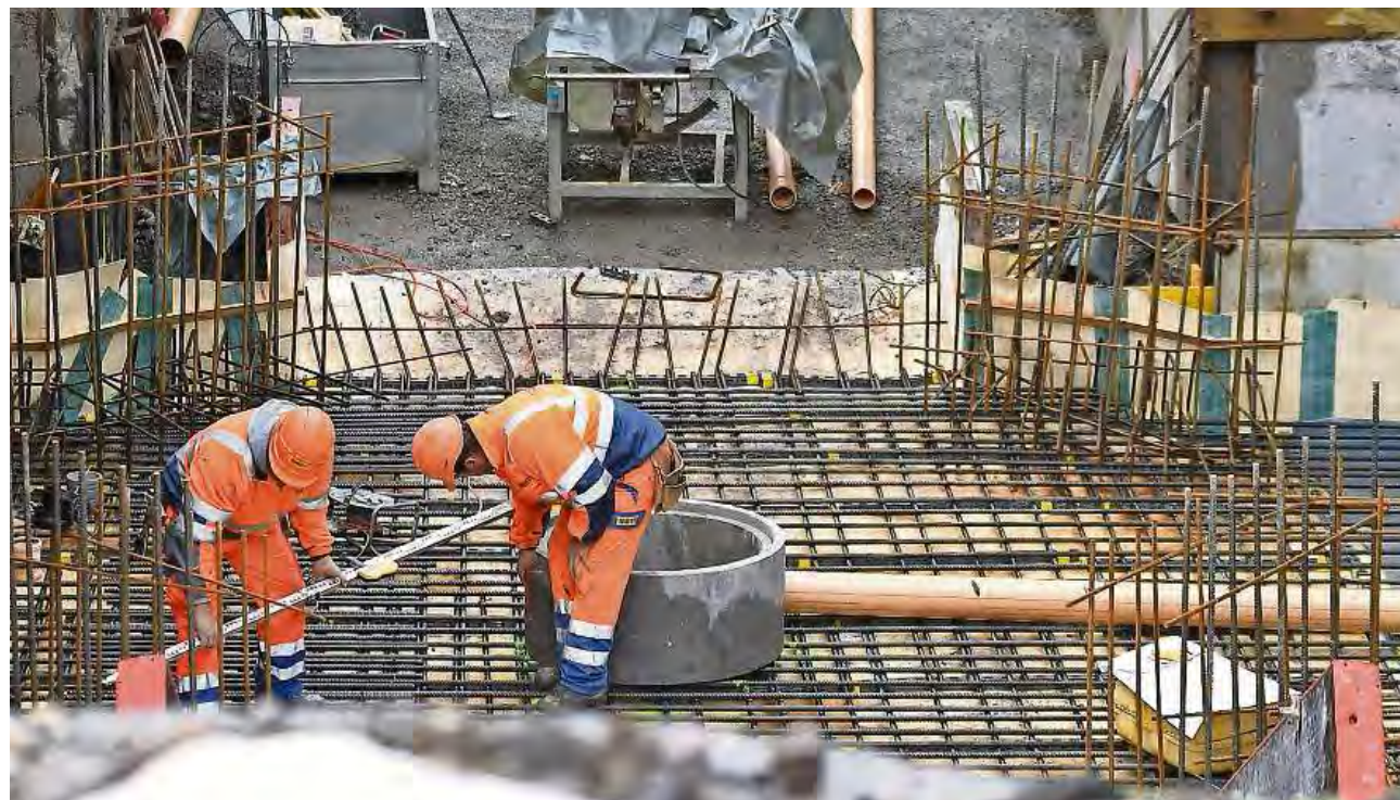
Es geht voran: Die Bauarbeiten an der Unterführung sind im Februar des kommenden Jahres zu Ende.
