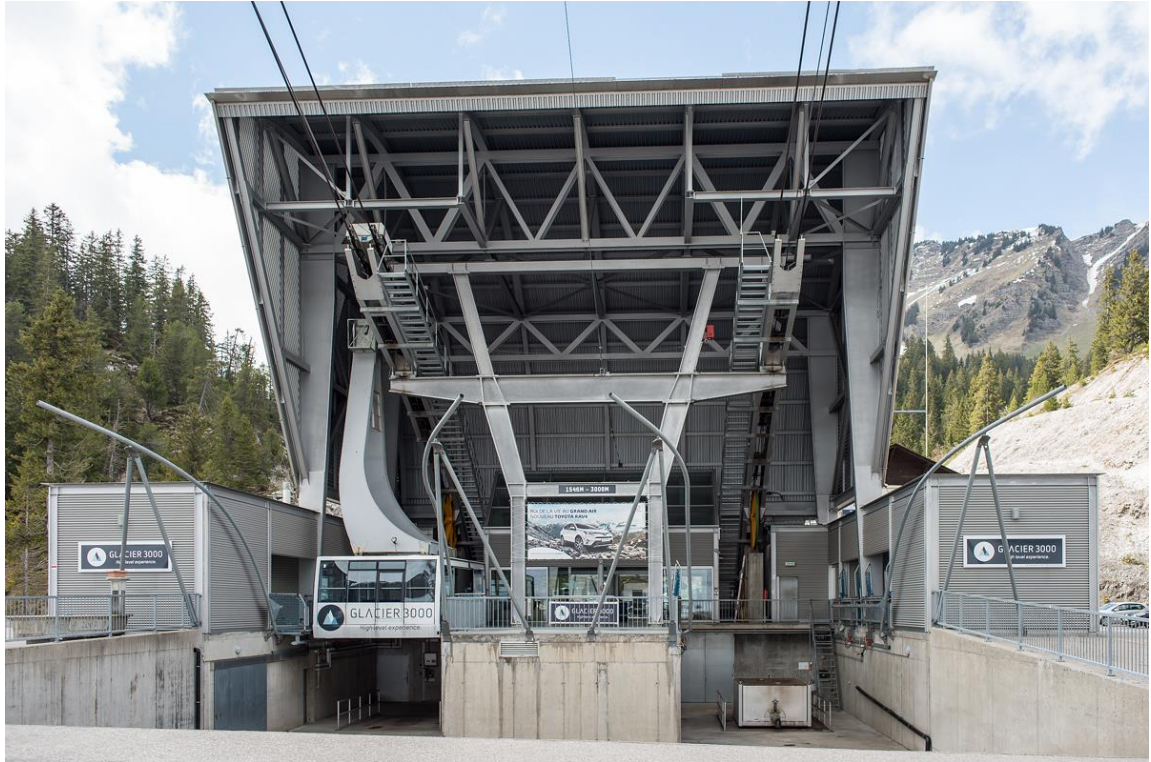
Abbildung 15: Niederflureinstieg bei der Pendelbahn Col du Pillon – Cabane des Diablerets (Quellen: Ingo Konrad Müller, www.bahnbilder.de )
