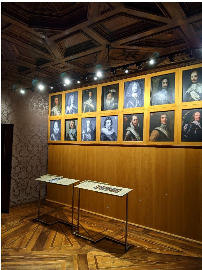
Abbildung 9: Beleuchtungsersatz Freulerpalast, die LED Leuchten sparen nicht nur Energie sondern schonen zusätzlich auch die Bilder, da das Licht keine UV Strahlen enthält
