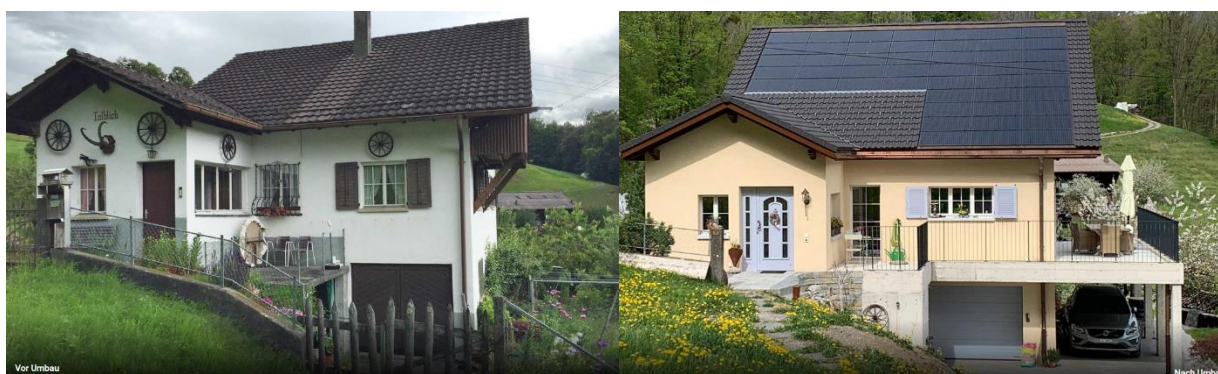
Abbildung 4: Beispiel vor und nach dem Umbau Gesamtsanierung
