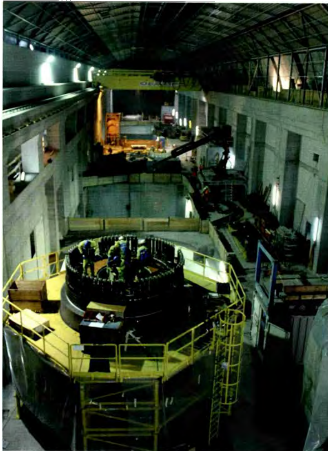
Bild 4. Die fertiggestellte Maschinenkaverne.
