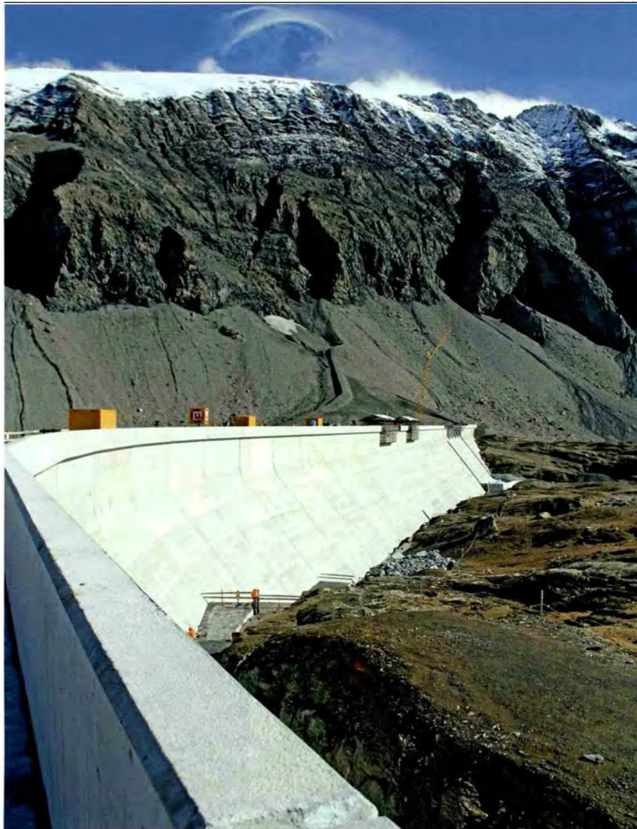
Bild 2. Die Staumauer November 2014.
