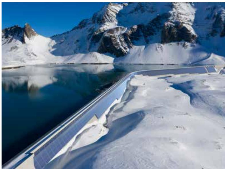
*Im Sommer 2021 wird auf der Staumauer Muttsee und damit auf einer technischen Anlage eine grosse Photovoltaikanlage mit einem beträchtlichen Winterpotenzial erbaut. (Axpo)*
