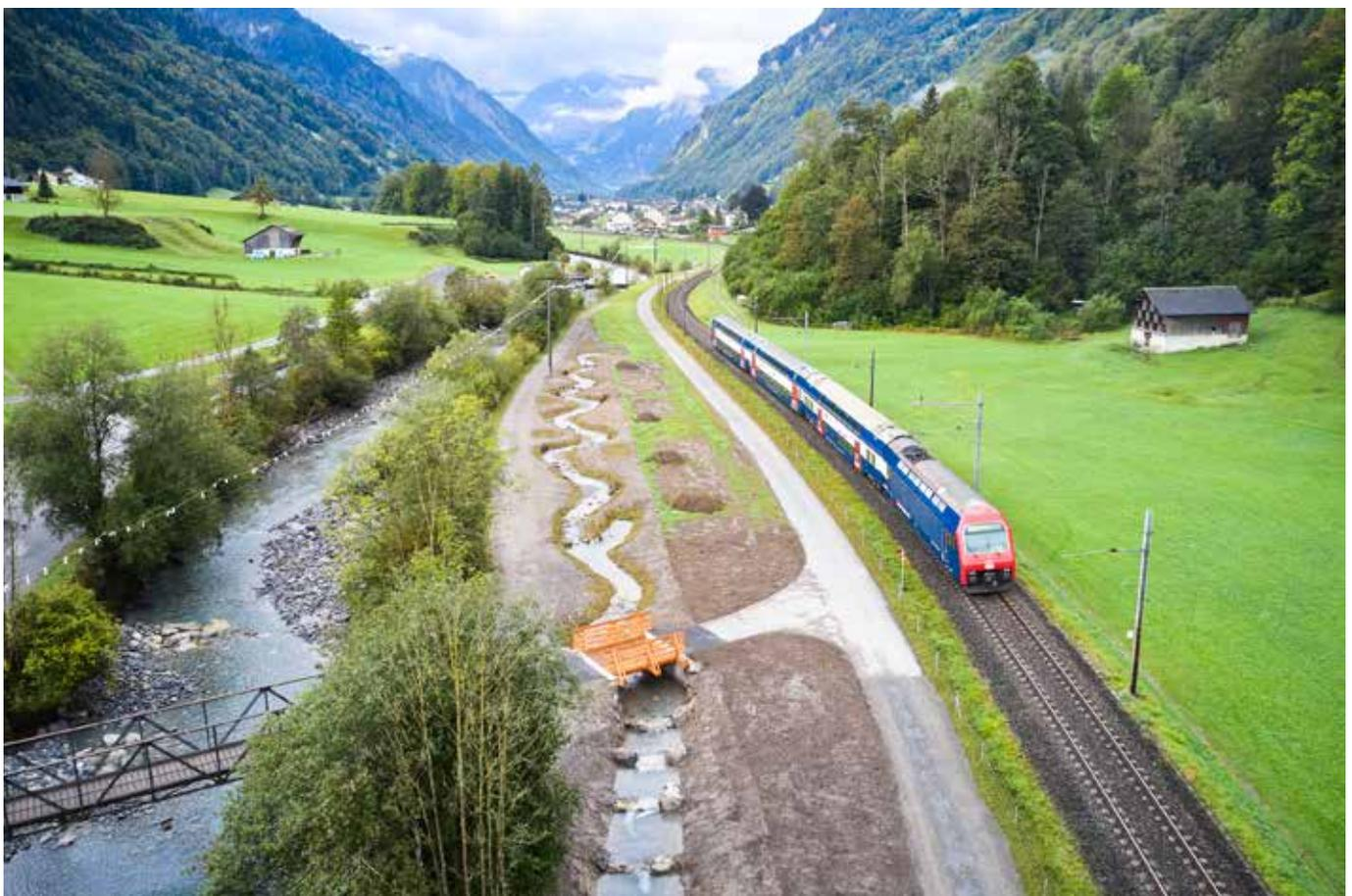
Der bisher in einem Rohr direkt in die Linth geführte Bach verläuft auf 200 m in einem naturnahen Gerinne (TBG).
