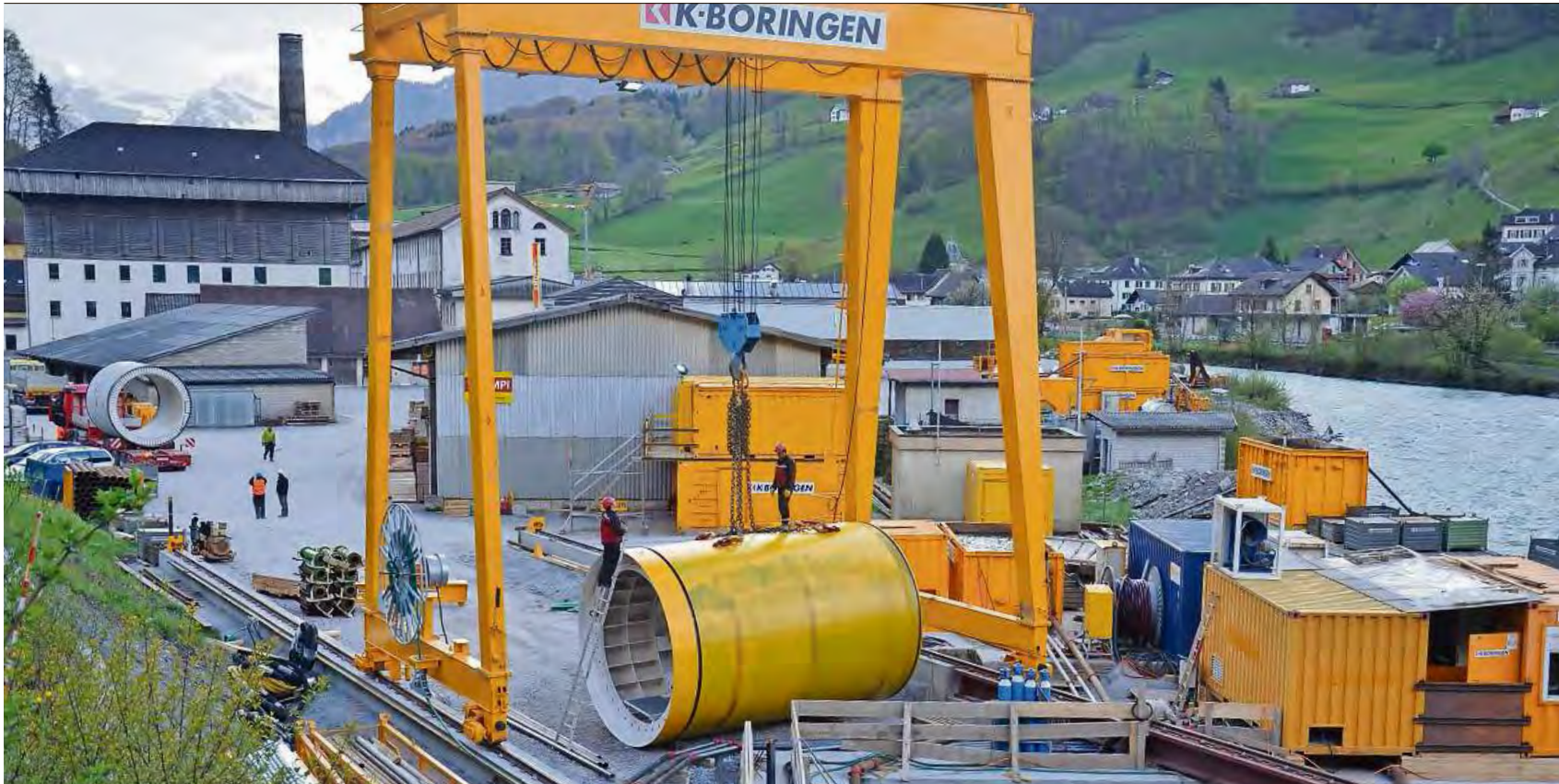
Aufgelaufen: Rohr um Rohr ist von der Kraftwerkbaustelle in Mitlödi her in den Berg gepresst worden – nun endet der Vortrieb von der «Doppelpower»-Talseite her.
