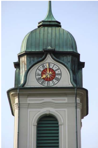
Näfels, Kath. Kirche, Kirchturm
