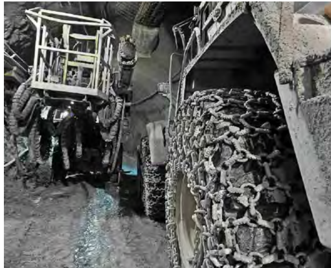
180 000 Kubikmeter Fels mussten ausgebrochen werden
