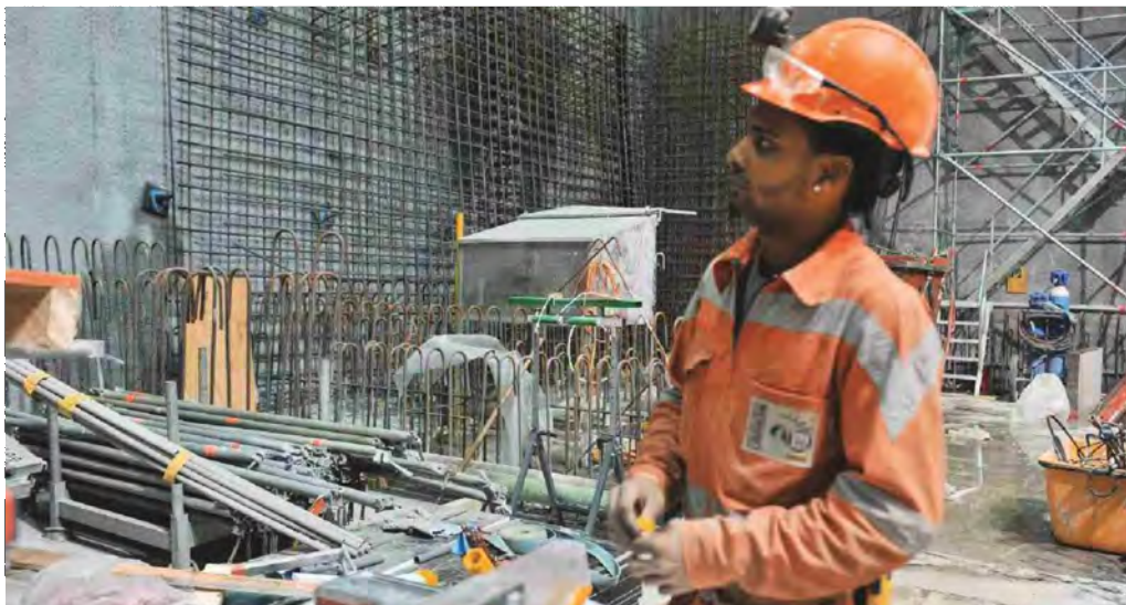
Ausbau der Maschinenkaverne. Zeitweise sind bis zu 800 Arbeiter im Einsatz
