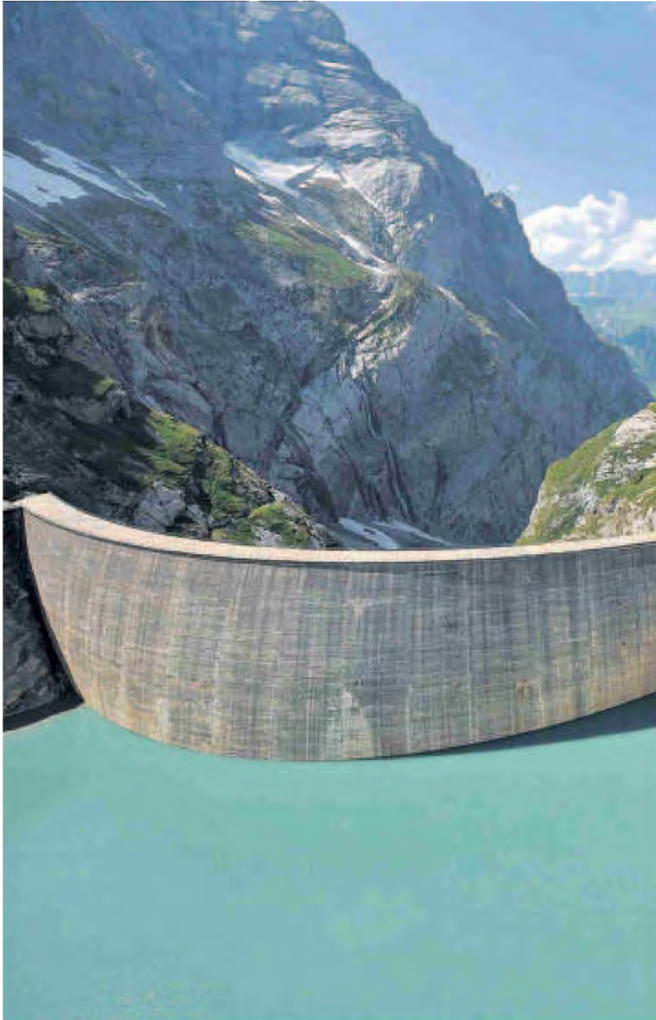
Bogenstaumauer des Kraftwerks Linth-Limmern im Glerner Hinterland. Der Stausee liegt 1800 Meter über Meer.
