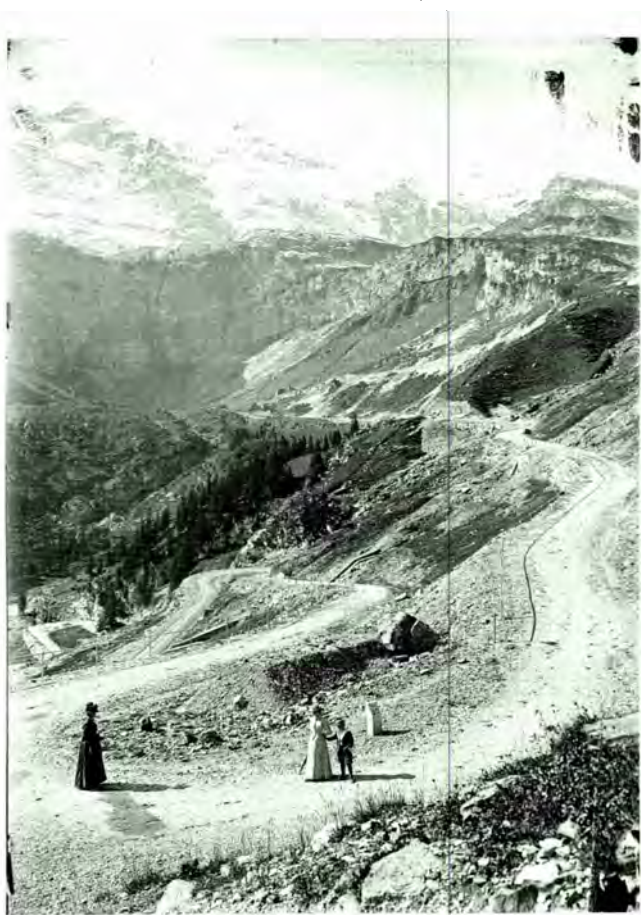
Serpentinen in der Vorfrutt, als Schotterstrasse um 1900 und «staubfrei» 1930. Rechts die Strasse, wie wir sie heute kennen.
