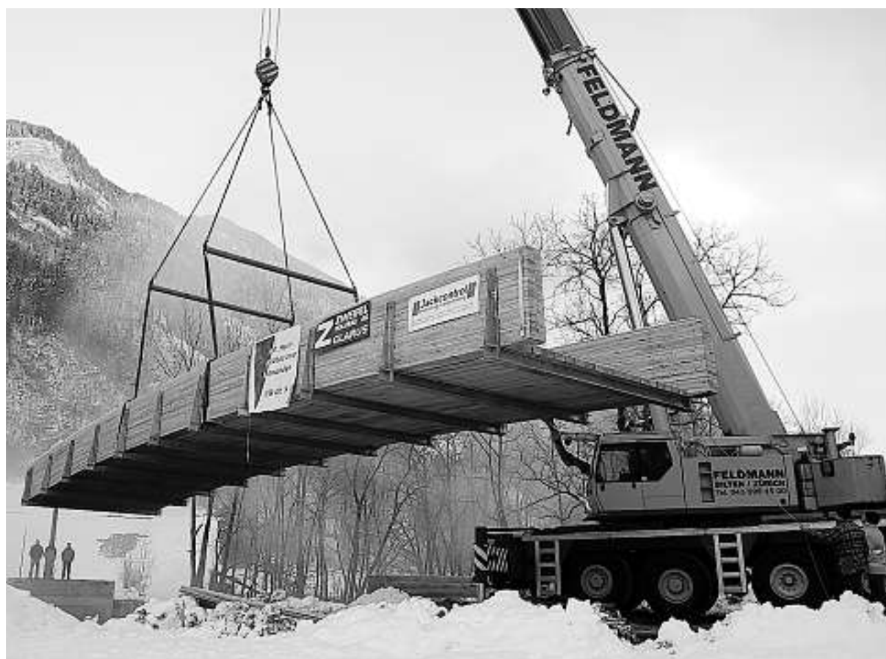
Mit dem Kran aufs Fundament: Die neue Loipenbrücke schwebt zu ihrem Bestimmungsort.
