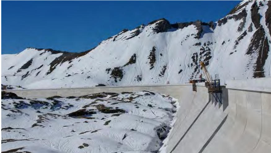
Die Schwergewichtstaumauer auf der Muttenalp steht. (Bild: PD)
