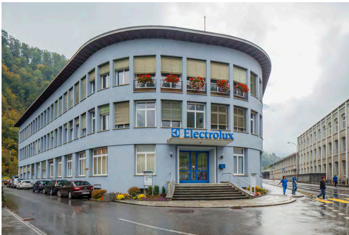
1 | 4 Hier werden bis heute Haushaltgeräte produziert: Das Gebäude von Electrolux in Schwanden, Kanton Glarus. ( 24. September 2012) Bild: Gaetan Bally/Keystone
