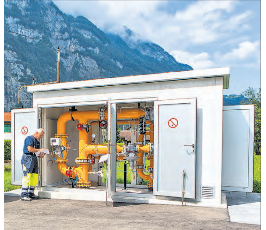
Die neue Druckreduzier- und Messstation Rollengut in Netstal. (Fotos: zvg)
