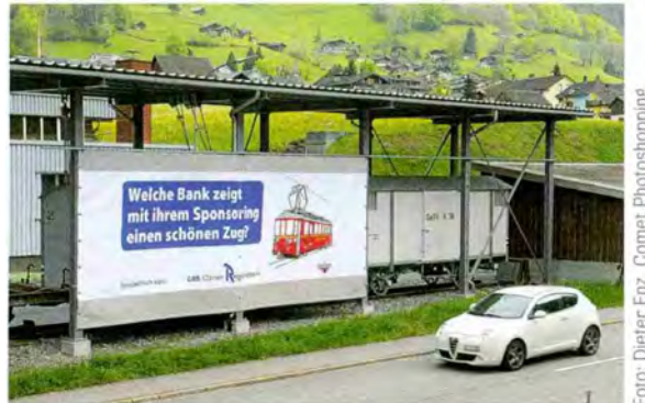
Überdachtes Museumsgleis bei der Station Engi Vorderdorf.
