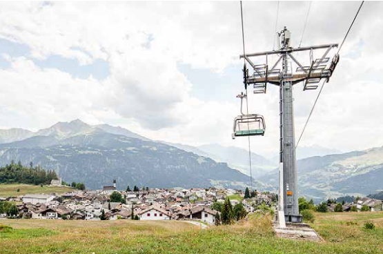
Mit dieser Mobilfunkantenne in Falera GR auf dem Mas- ten eines Sässellift befaste sich auch das Bundesgericht. Foto: B. Jurd, EspaceSuisse
