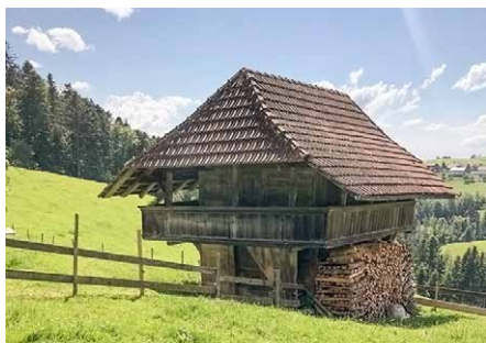
Dieser alte Speicher ist im Bauinventar des Kantons Bern als wertvolle Rarität aufgeführt. Foto: Adrian Wyss
