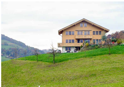
Dieses widerrechtlich erstellte Wohnhaus im Kanton Bern darf nicht an Personen vermietet werden, die nicht in der Landwirtschaft tätig sind. Foto: J. Poux, EspaceSuisse
