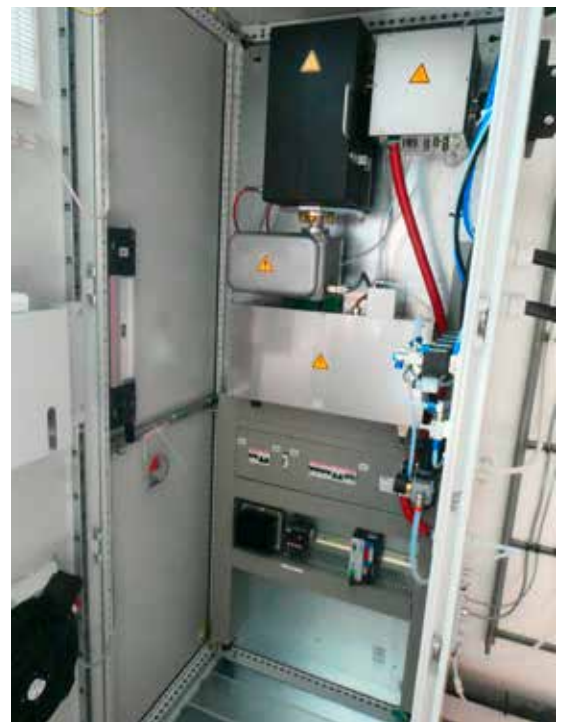
Die Messeinrichtung zur Bestimmung der Quecksilberkonzentration in der Abluft (AUE)
