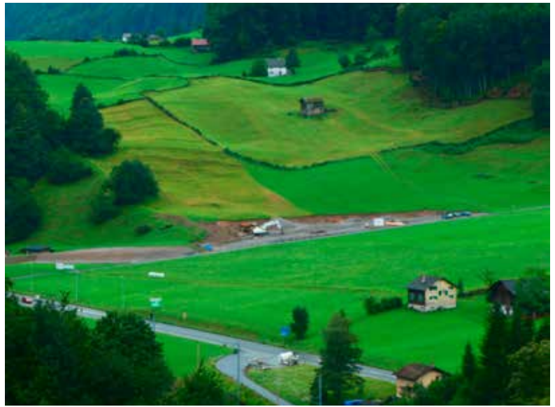
Am neuen Deponie-Standort Däniberg wurde im August 2020 eine erste Etappe abhumisiert und steht für die Auffüllung bereit.
