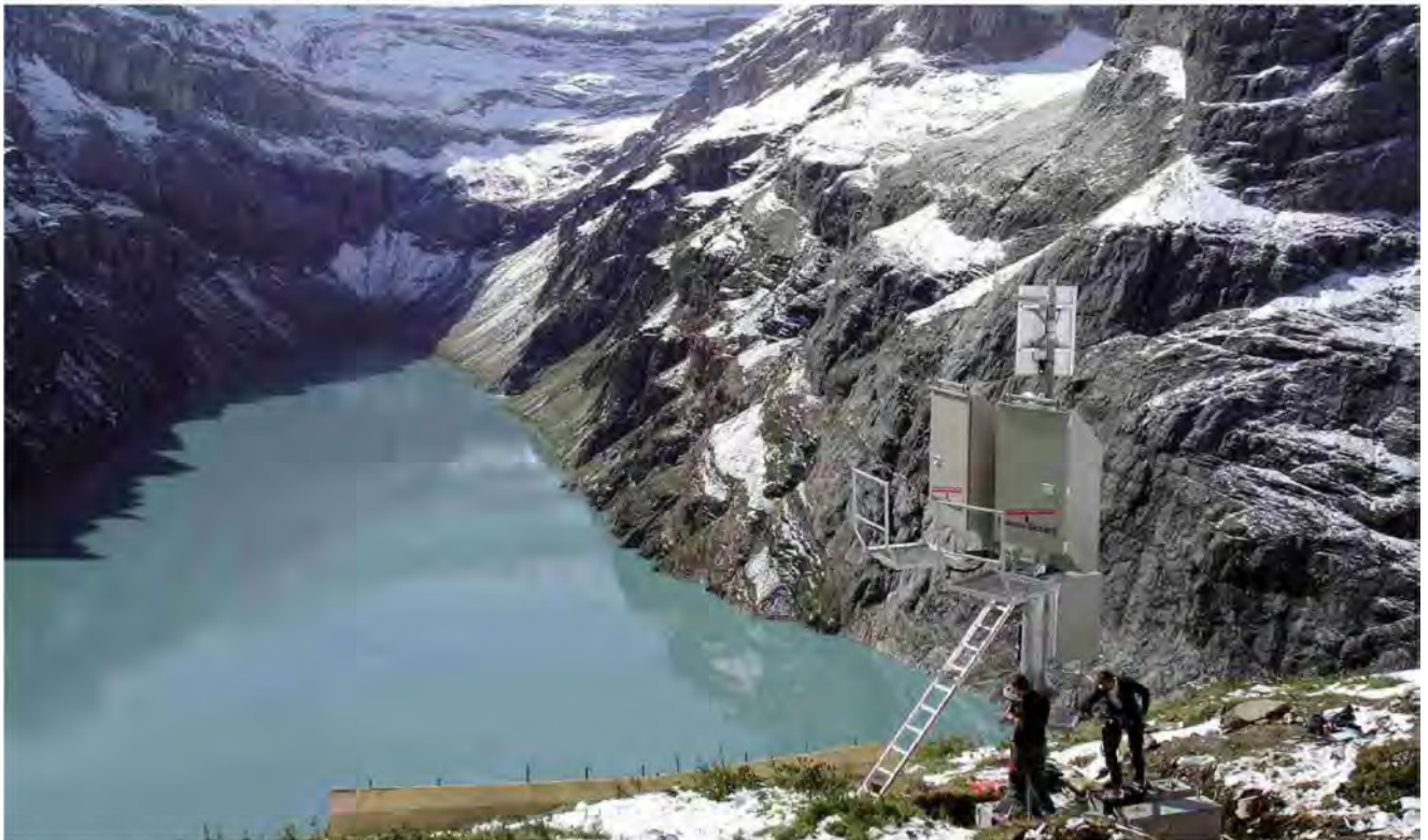
Die Inauen-Schätti AG bietet die künstliche Lawinenauslösung mit dem Lawinensicherheitssystem «Lawinenwächter» für Skigebiete und Verkehrswege an. Auf dem Bild sieht man einen der drei Lawinenmaste der Baustelle «Linthal 2015» KLL im Kanton Glarus.
