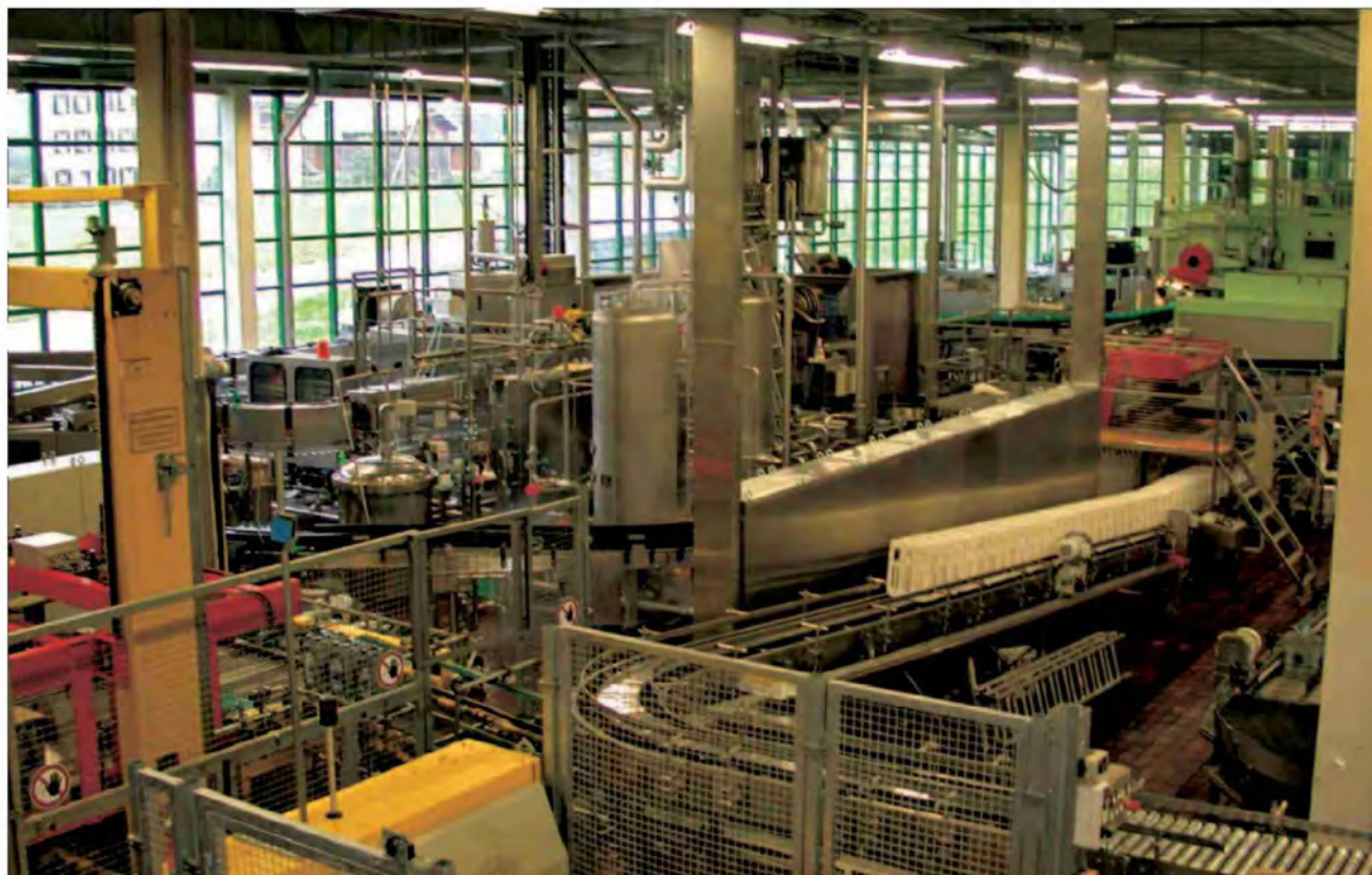
Blick in die moderne Produktionshalle.
