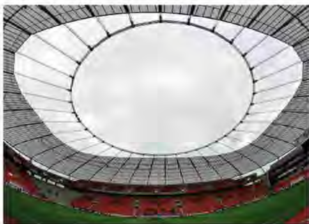
Das Stadion von Bayer Leverkusen hat ein neues Dach erhalten. 500 Tonnen Seile mit Durchmessern von 70 bis 90 mm hat die Inauen-Schätti AG zu einer Dachkonstruktion gespannt, welche die neuen Dachelemente tragen.
