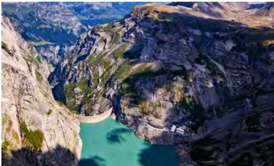
Ungewisse Zukunft: Pumpspeicherkraftwerk am Limmerensee im Kanton Glarus
