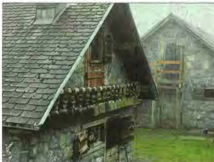
Alpgebäude wurden direkt an einer Quelle erbaut (linkes Gebäude mit Käserei unten und Schlafzimmer oben). Der Stall ist nicht in Sichtweite.
