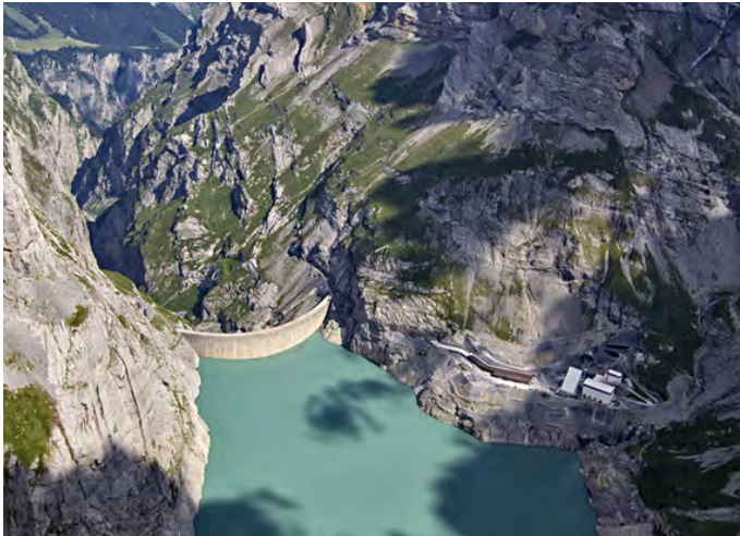
Das sich im Bau befindliche Pumpspeicherwerk «Linthal 2015» in Glarus soll eine Pumpleistung von 1000 MW aufweisen. keystone
