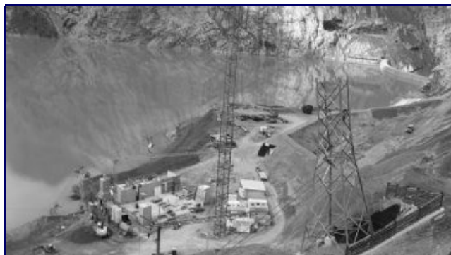
Blick auf die Baustelle des Pumpspeicherwerks Linthal. (Archivbild) / Foto: Axpo
