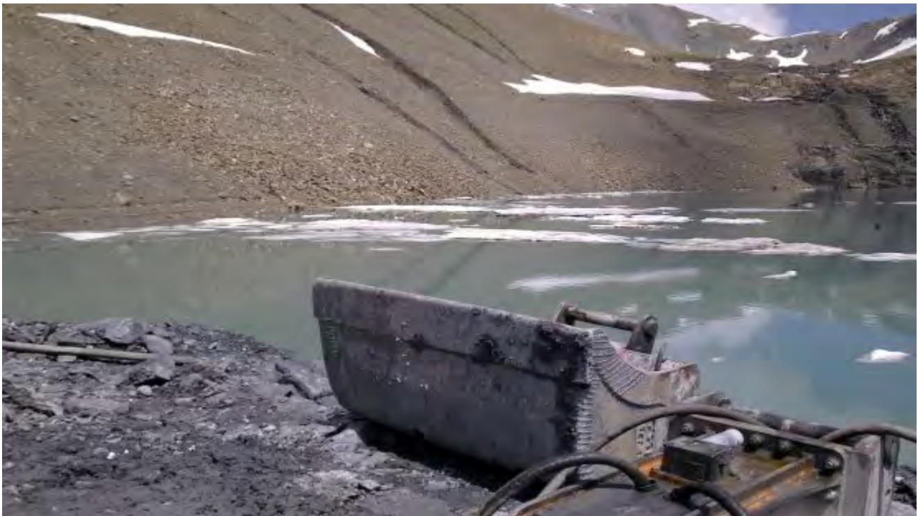
Bauarbeiten am Muttsee im Glarnerland. (Bild: Keystone)
